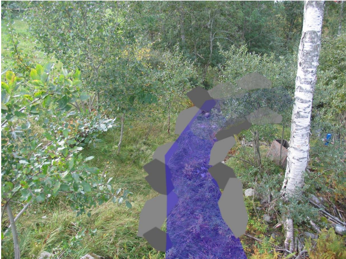
Figur 12. Fiskepassasjen med løp i dagen, nedstrøms demningen/veien. Foto: Odin Kirkemoen.
