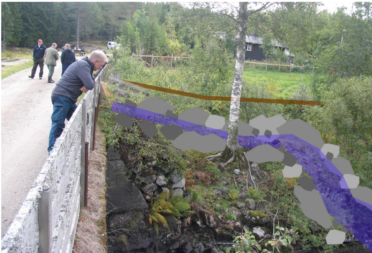
Figur 11. Fiskepassasjen med løp i dagen, nedstrøms demning/vei/kulvert. Steinsetting i både inner- og yttersvinger, og på nedsiden av løpet. Gjennomsnittlig bredde = 1,5 m, minimum dybde = 10 cm, anslått lengde = 10-12 m. Bunnen av elveløpet består av mindre steiner og grov grus. I overkant av det nye bekkeløpet bør det legges en flomvoll for å beskytte jordet på oversiden (brun linje). Foto: Odin Kirkemoen.
