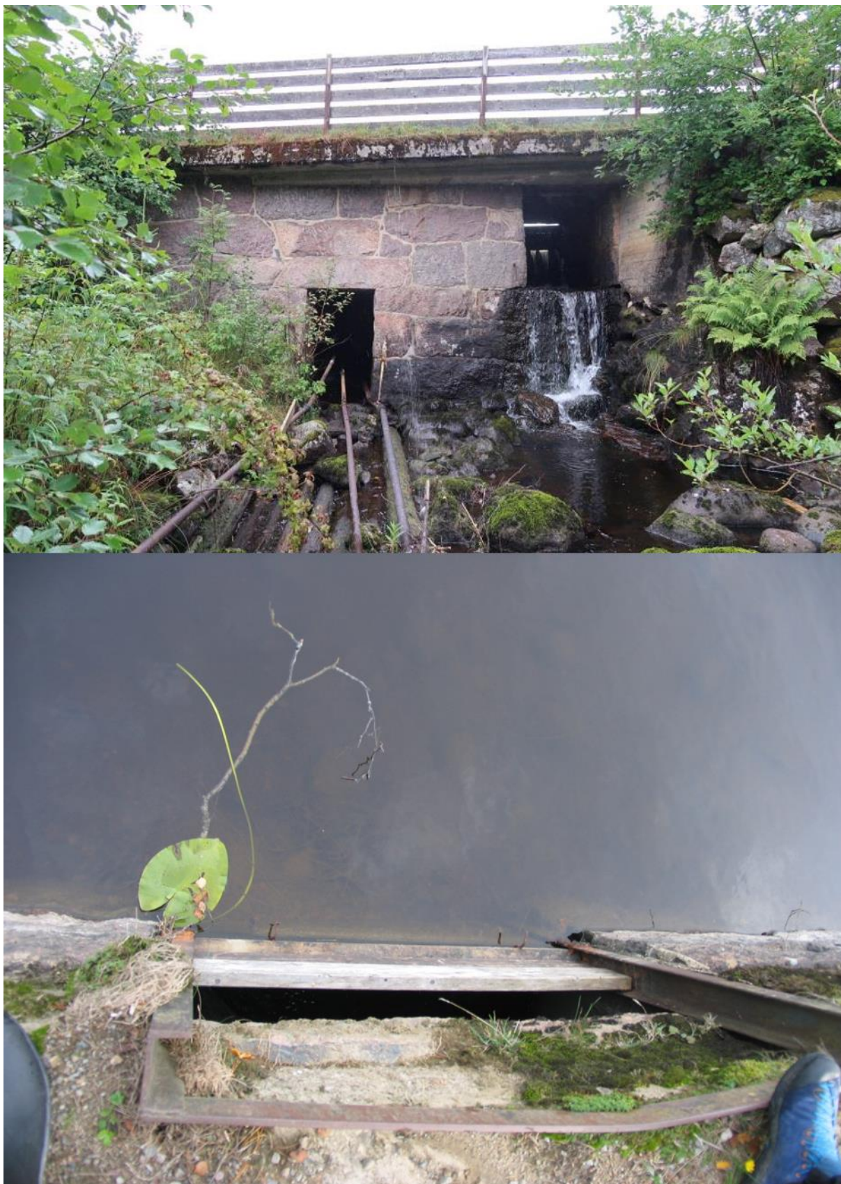
Figur 4. Lysjødammen, vannets eneste vei nedover til Lysjøåa/Holtåa, gjennom/over damluka og under Lysjøvegen. Dammen danner et vandringshinder med et 2,5 m vertikalt fall. Foto: Odin Kirkemoen.
