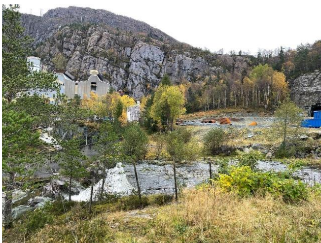
Figur 5-21 Bildet viser høydeplatået der deler av anlegget til smelteverket ligger til venstre og trafostasjonen ligger lenger oppe til venstre sett fra sørsiden av Svelgselva ved terskelen i elva.
