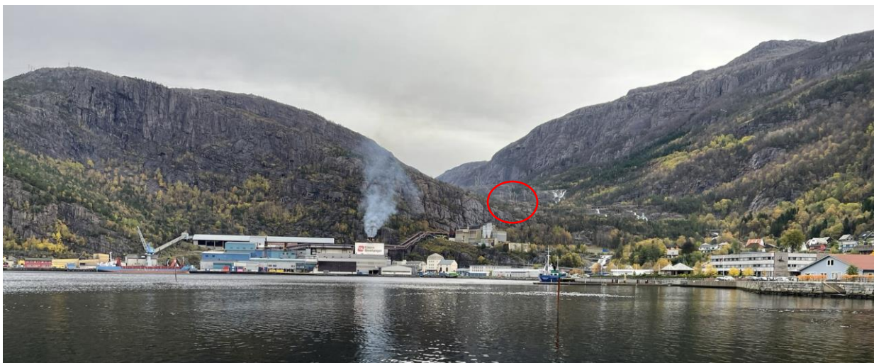
Figur 6-7 Fra Naustneset ser man mot industriområdet. Området hvor utvidelse av trafostasjonen skal skje er også godt synlig fra delområdet (rød sirkel). Til høyre i bildet ser man kaipromenaden som går i front av omsorgssenteret og videre mot den gamle dampskipskaien, Firda Billag og hotellet.
