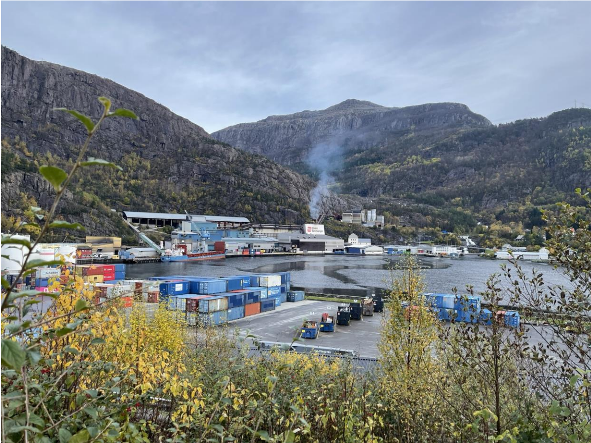
Figur 6-26 Utsikt fra delområdet mot verftsområdet. Området hvor utviding av transformatorstasjon ligger i fjellsiden ovenfor verftsområdet.
