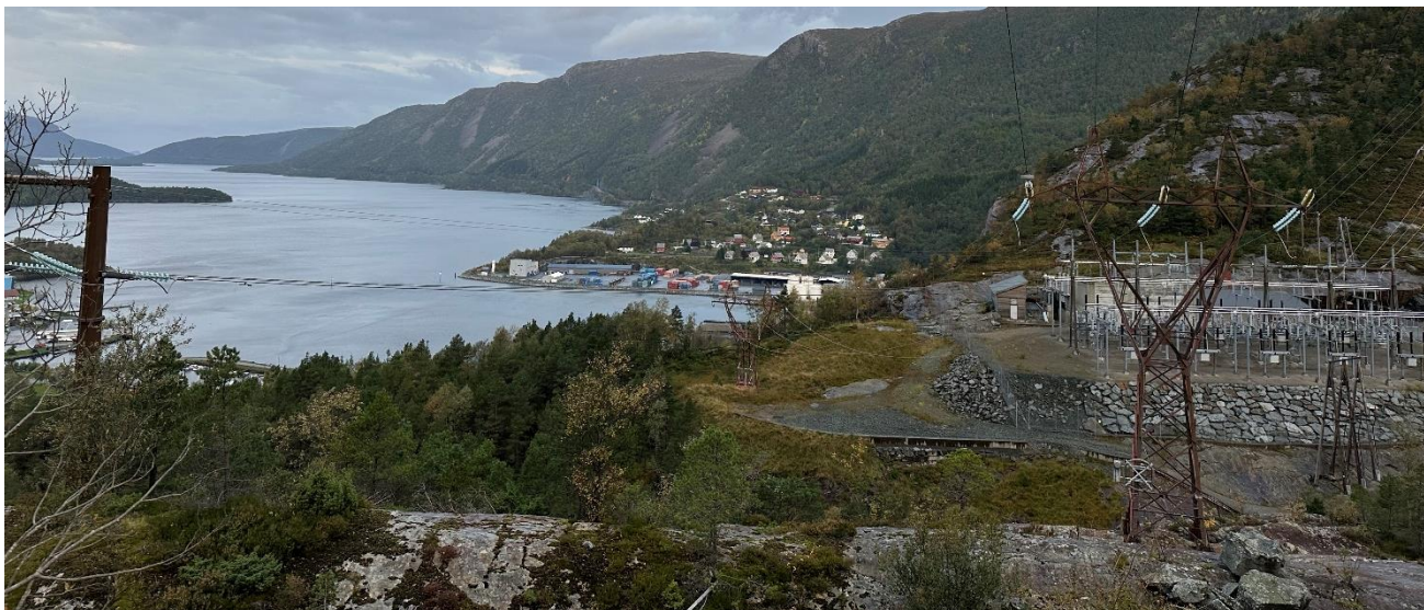
Figur 5-33 Bilde sett fra Hornelsvegen (fv. 614) med eksisterende situasjon ved Svelgen trafostasjon til høyre i bildet.
