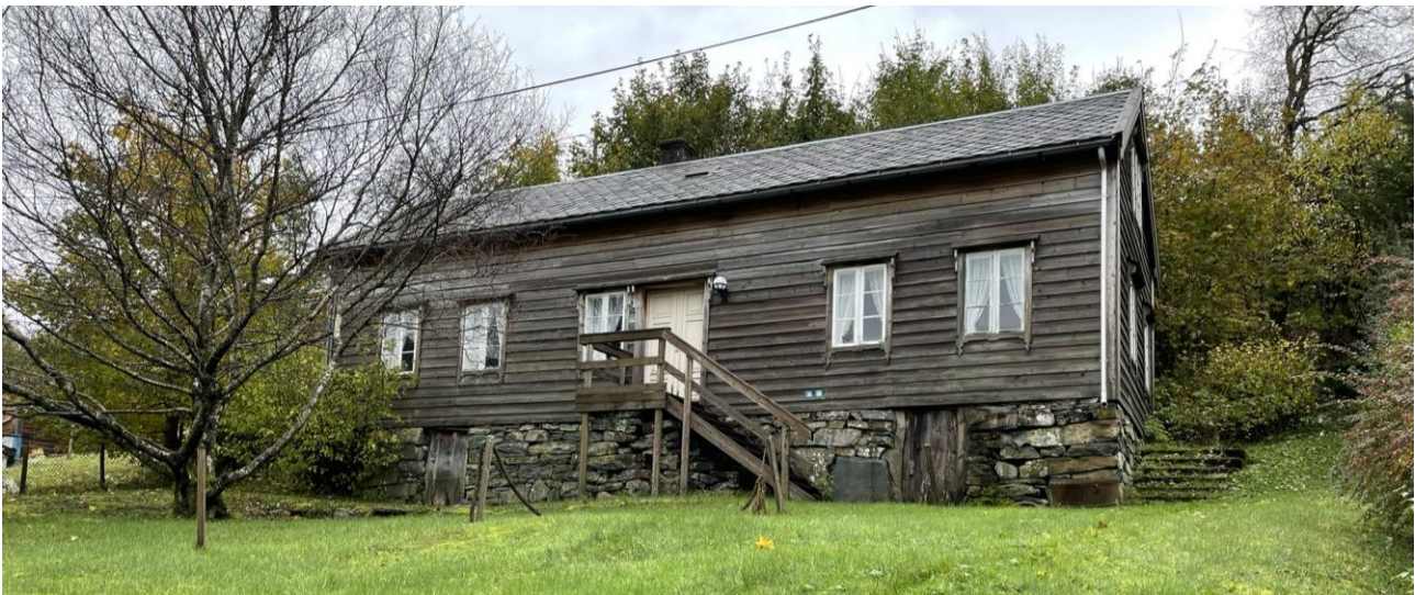
Figur 6-14 Stovehuset i Øyratunet.
