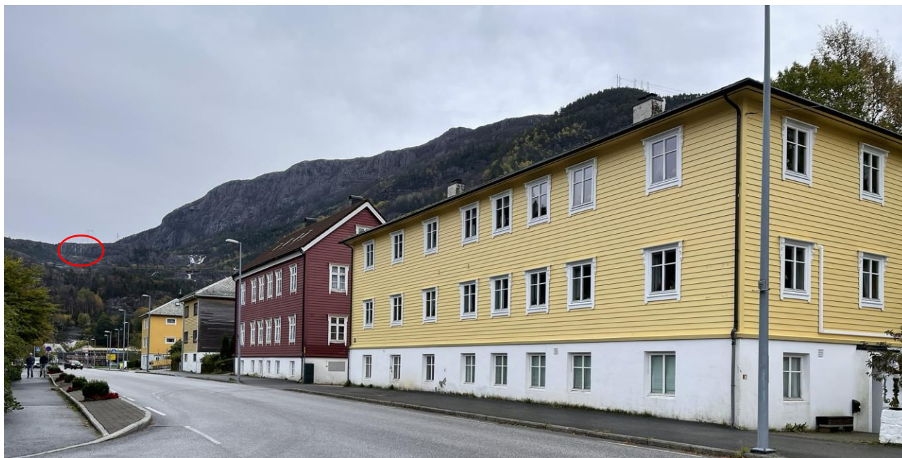
Figur 6-24 Fra Gunnar Schelderups veg og mot transformatorområdet.
