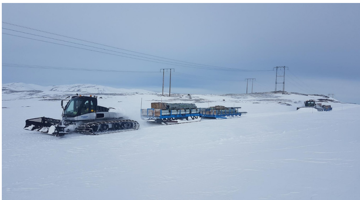
Figur 35: Vintertransport av mastemateriell. Her fra bygging av ny 420 kV ledning mellom Balsfjord og Skillemoen.
