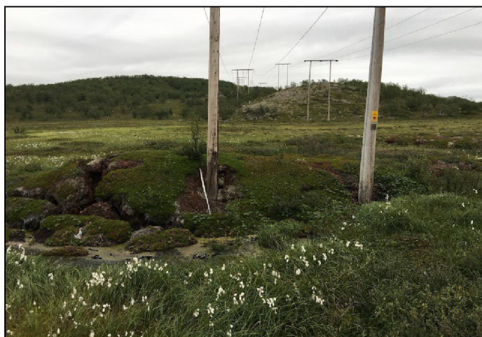
Figur 8: Foto av en mast for eksisterende 132 kV ledning som går gjennom Madarjeaggi, en palsmyr nord for Stabbursdalen.
