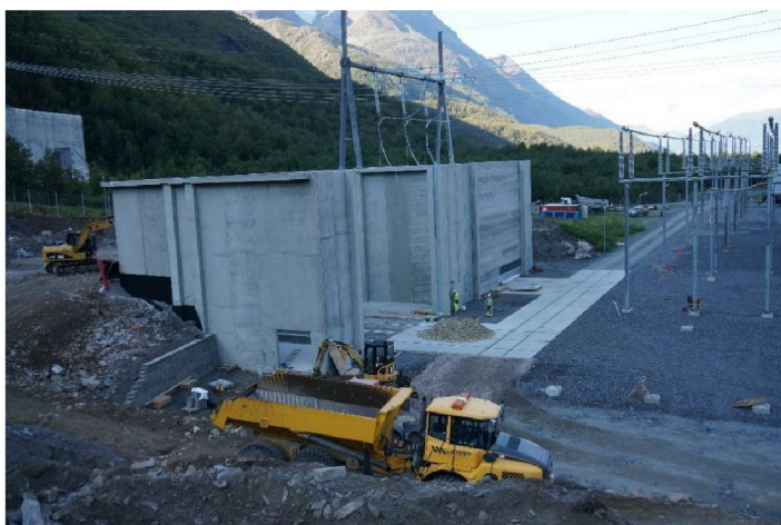
Figur 25: Eksempel på transformatorsjakt i betong
