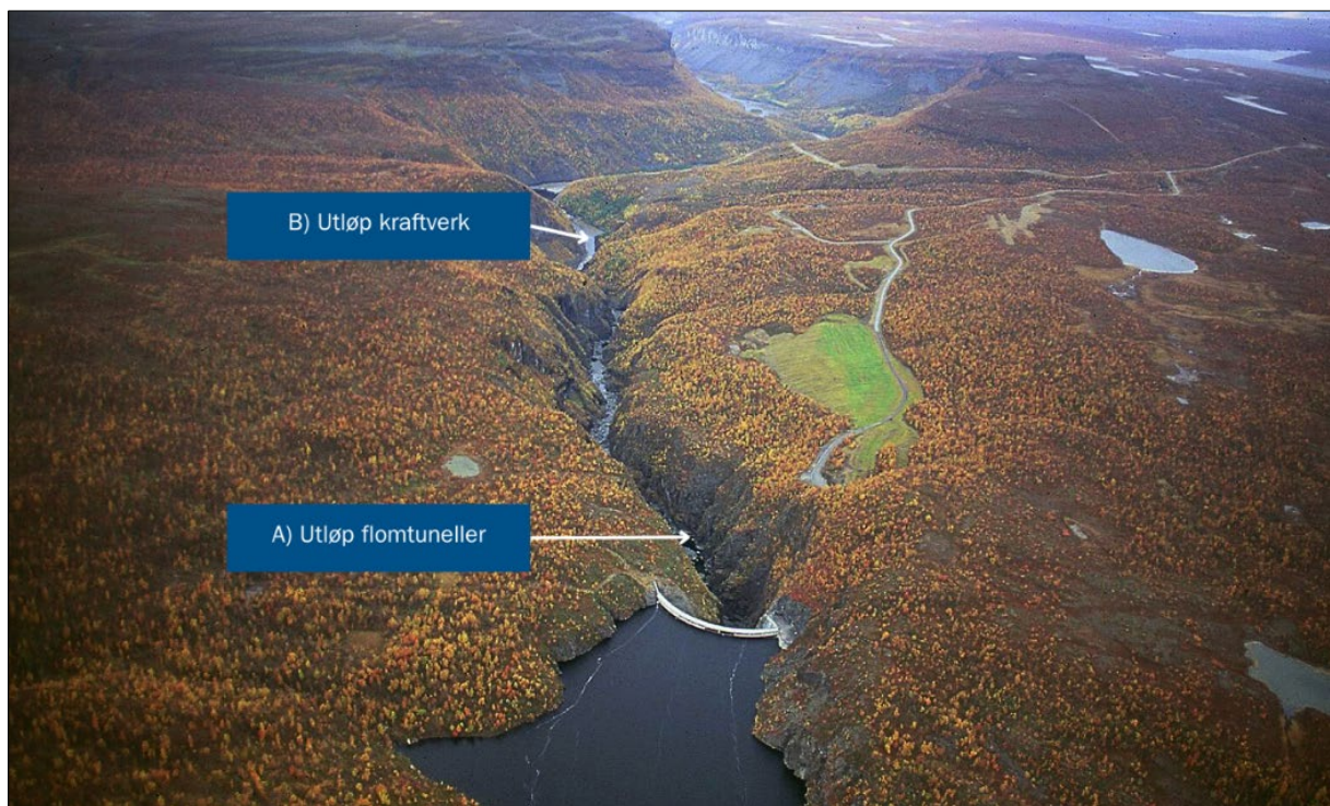
Figur 2. Oversiktsbilde over området fra dammen og ned mot portalbygget. Foto tatt mot nord. Foto: Statkraft.
