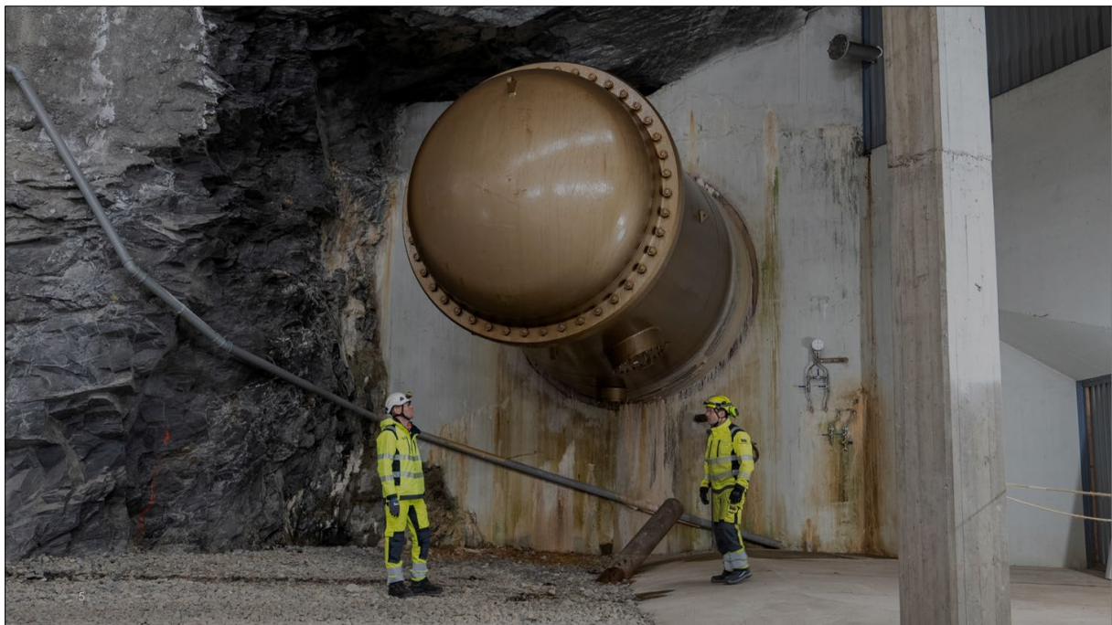
Figur 4. Dagens situasjon i kraftstasjonen. Vannrør fra tilløpstunnelen til et tredje aggregat (A3) er allerede klargjort fra opprinnelig utbygging. Foto: Statkraft.
