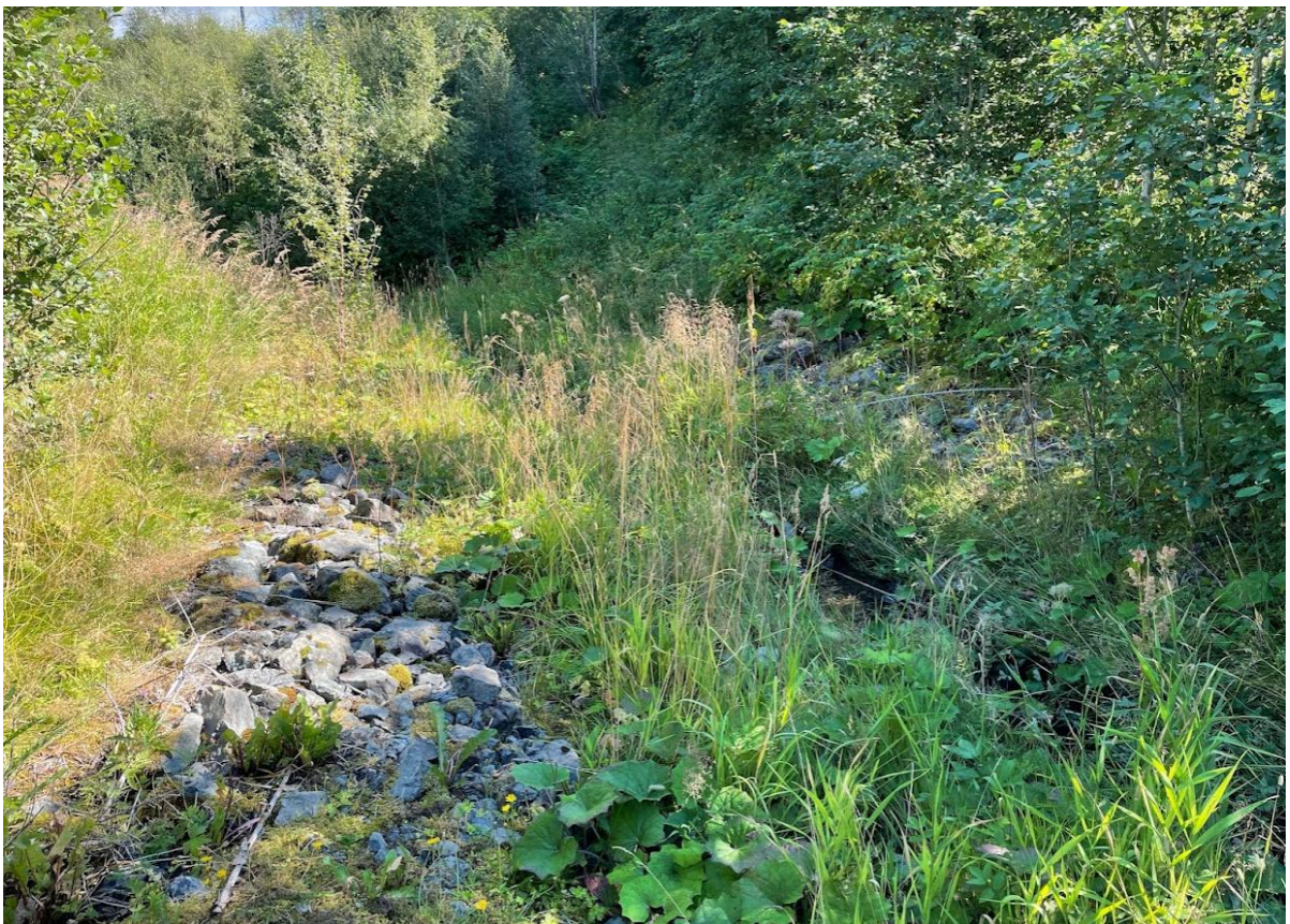
Figur 10: [5] Befaring 11. august 2021. Erosjonssikret bekk.
