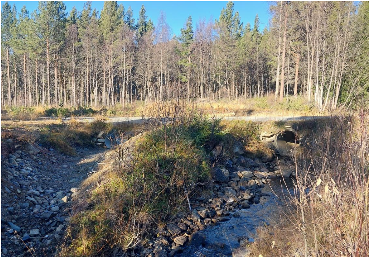
Figur 7: Foto av Storebekk ved Vikavegen (nummer 2).
