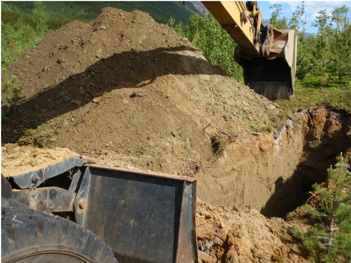
Bilde 5 PG.36. Det er sandmasser i øvre lag. Underliggende masser er grus og steinholdig sand.
