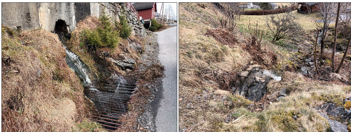
Figur 12: Bildet viser bekke-/ elveløp som drenerer i rør
