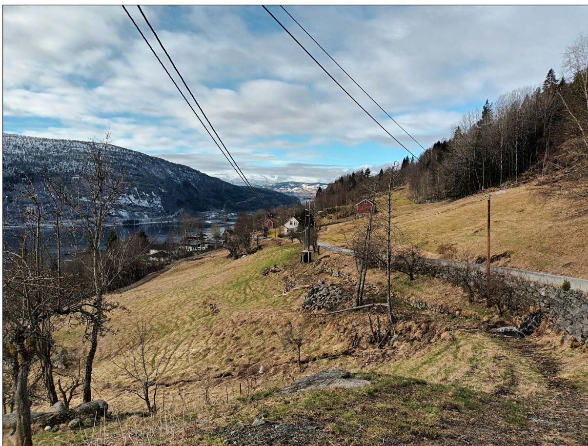
Figur 21: Dreneringsvei gjennom midtre deler av påvirkningsområdet. Bildet viser dreneringsvei som renner gjennom rør under dagens bilvei. Infopunkt 2.
