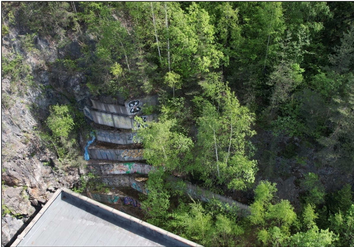
Figur 12: Støttemurer etablert i flere nivåer oppover skråningen. Basert på flyfoto antas tiltaket å være etablert i perioden 1984-1987.
