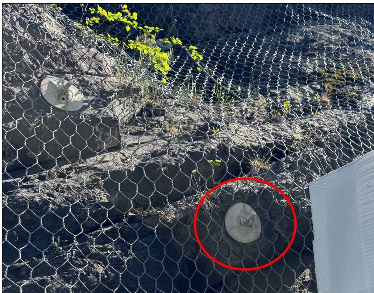
Figur 8: M20 bolter og steinsprangnett i den nordvestvendte bergskjæring øst i kartleggingsområdet. Rød sirkel angi eksempel på bolt klassifisert som B4.
