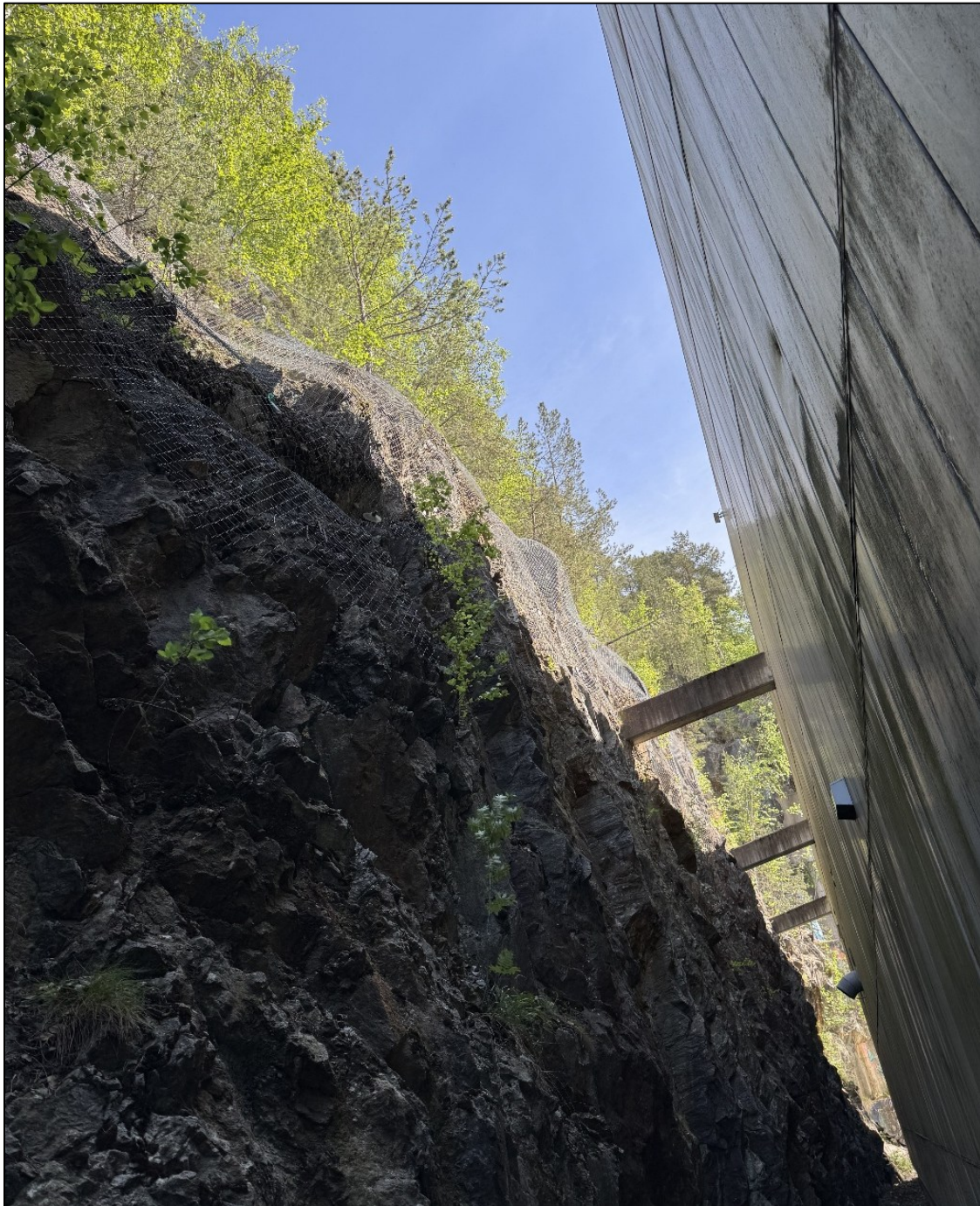
Figur 10: Vest-sørvestvendte bergskjæringen, hvor det er "hagenett" i toppen av bergskjæringen, samt avstivende betongbjelker.
