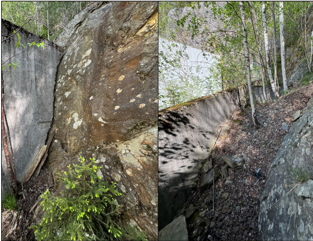
Figur 13: Nærbilde av en av støttemurene.
