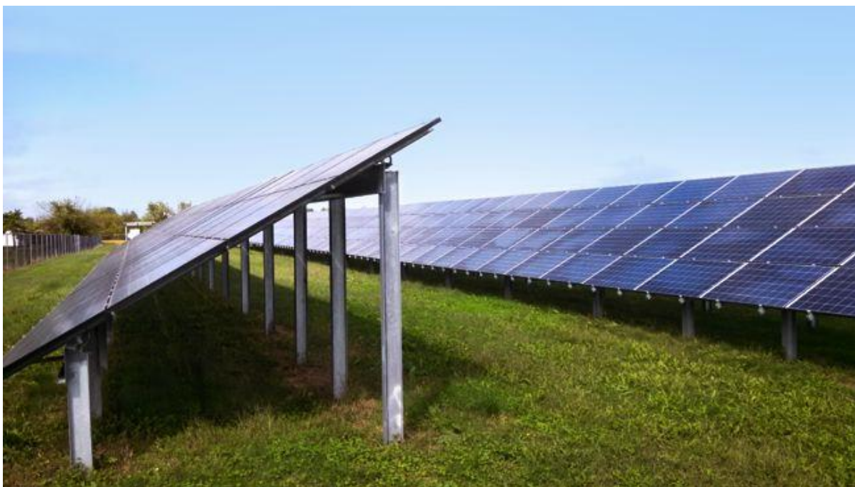
Figur 3-3 Fast-vinkel installasjonsløsning (foto: Willowbrook Solar).
