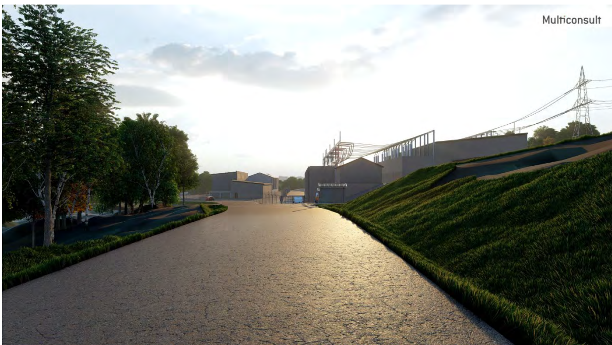
Figur 22: Tilleggssøkt transformatorstasjon sett fra omsøkt vendhammer (denne skal tildekkes med vekstlag etter at stasjonen er satt i drift, noe som ikke fremkommer av denne visualiseringen)
