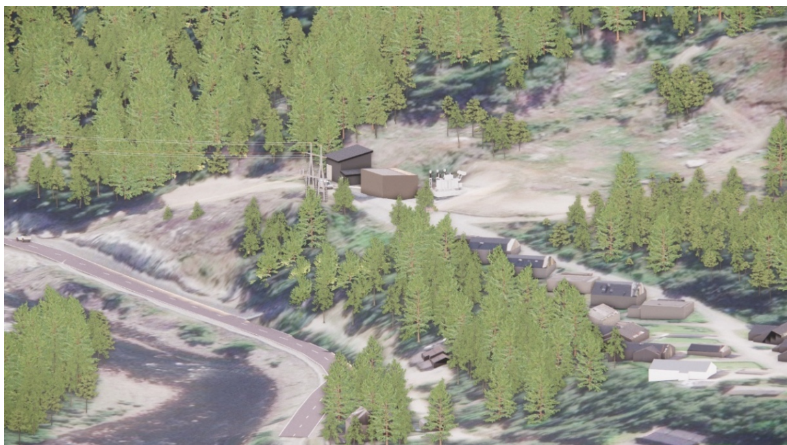
Figur 5-11: Ny Klyve transformatorstasjon sett fra vest mot øst
