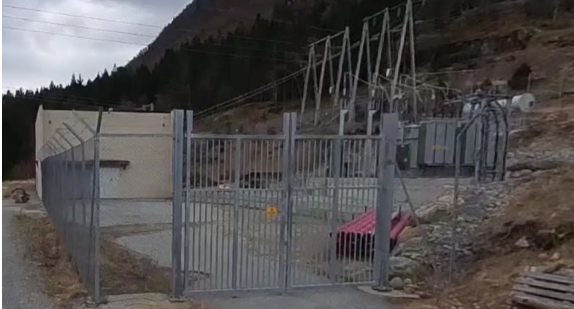
Figur 2-4: Eksisterende Klyve transformatorstasjon sett fra vest.
