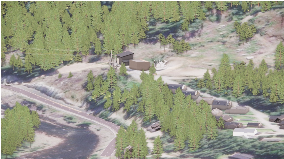
Figur 1-8: Klyve transformatorstasjon med nytt innendørs bryteranlegg, sett fra nordvest.
