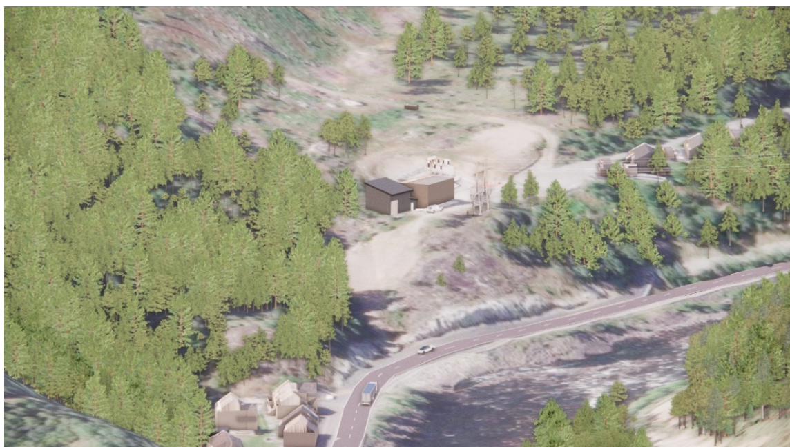
Figur 5-10: Ny Klyve transformatorstasjon sett fra øst mot vest
