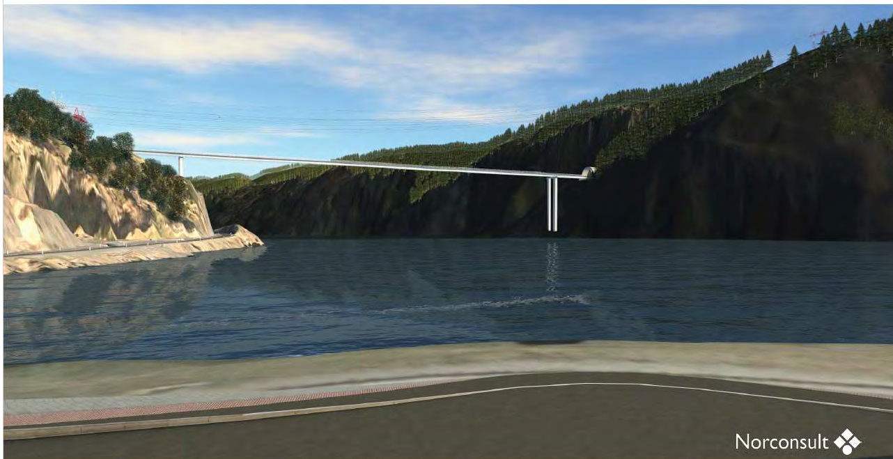
Figur 3. Illustrasjonen viser brokryssing for ny E39 og alt. 2.0/2.1 + alt A ved kryssing av Fedafjorden.
