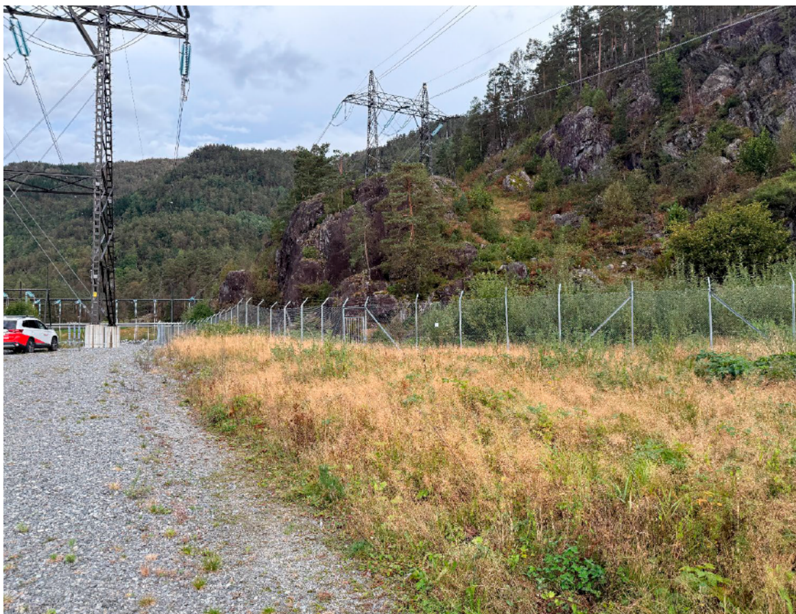
Figur 4: Der dagens gjerde går er det planlagt å legge ny kabel som skal forbinde ny transformator med kontrollanlegget. Statnett søker om å utvide stasjonstomten til å inkludere knausen midt i bildet og la nytt gjerde gå over knausen og til høyre for masten som vises i bakkant av bildet. Kilde: Statnetts konsesjonssøknad av 3. mars 2026.
