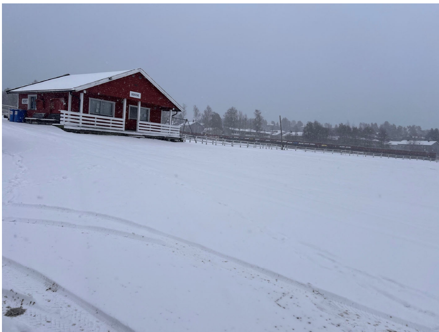
Figur 4. Bilde fra befaring 23.01.2025.
