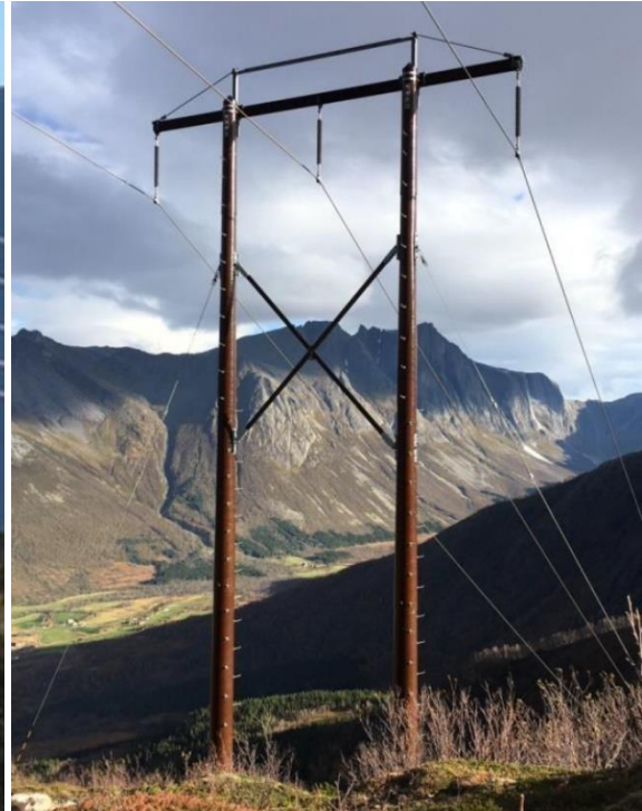
Figur 4-8 132 kV mast i kompositt.
