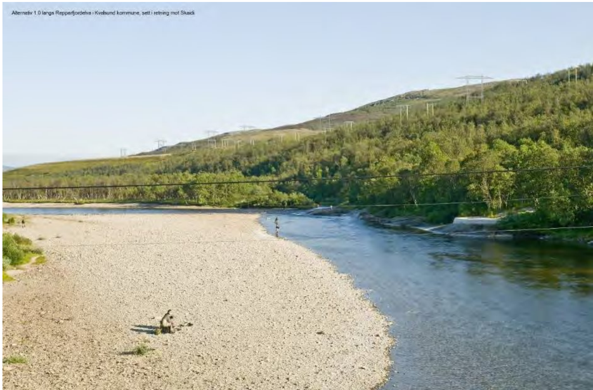
Figur 8-3. Ny 420 kV ledning langs Repparfjordelva sett retning mot Skaidi. Ved Repparfjordelva er det relativt frodig. Fotovisualisering: Einar Berg.
