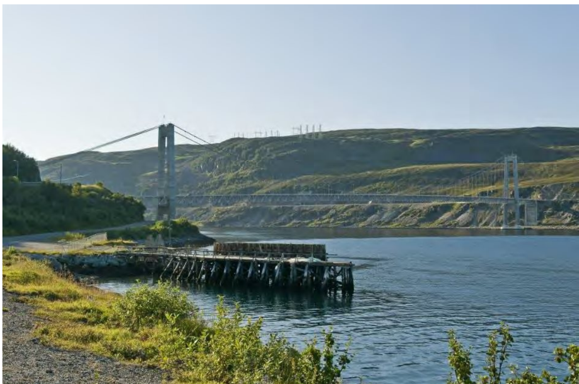
Figur 8-4. Ved kryssing av Kvalsundet må 420 kV ledningen føres ut på avspenningsbukker, som kommer i tillegg til de to settene med slike master som er der fra før. Fotovisualisering: Einar Berg.
