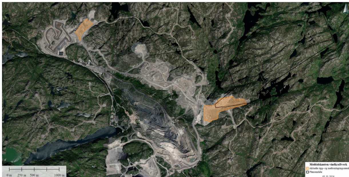
Figur 7: Ortofoto med angivelse av aktuelle områder for riggplass og mellomlagring.
