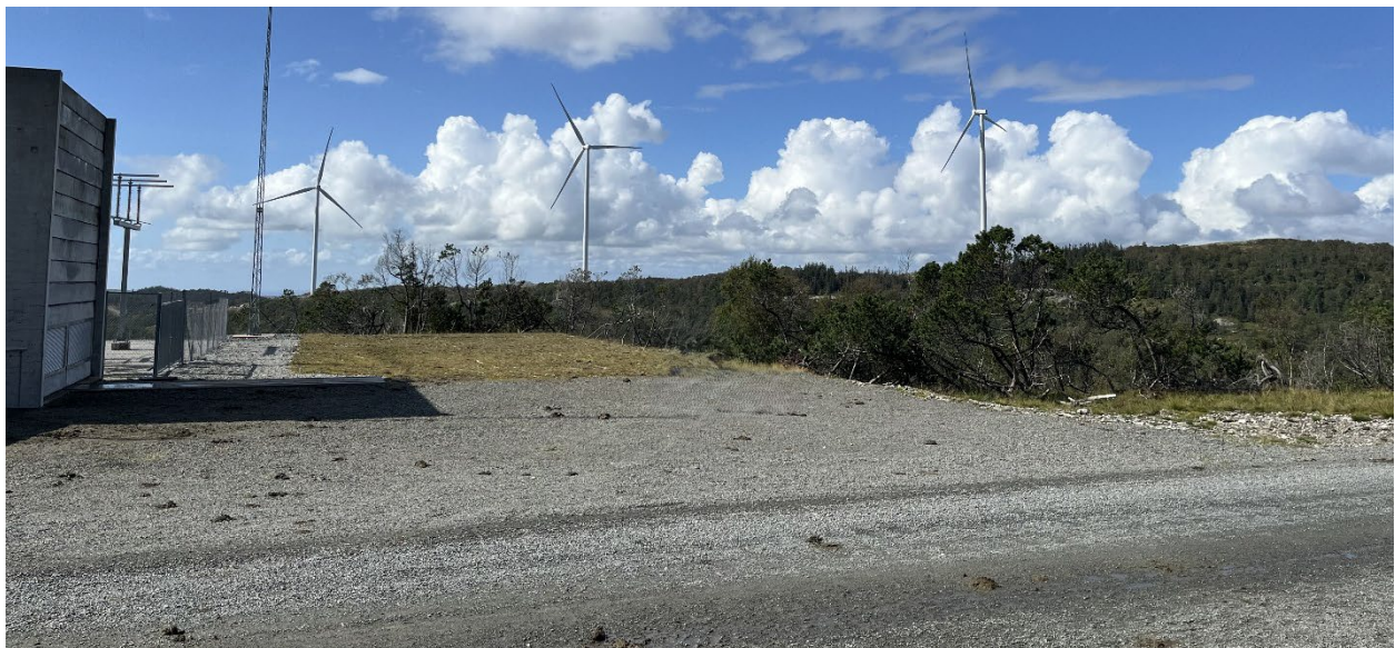
Figur 3 Foto av areal planlagt til installasjon av batterianlegg.
