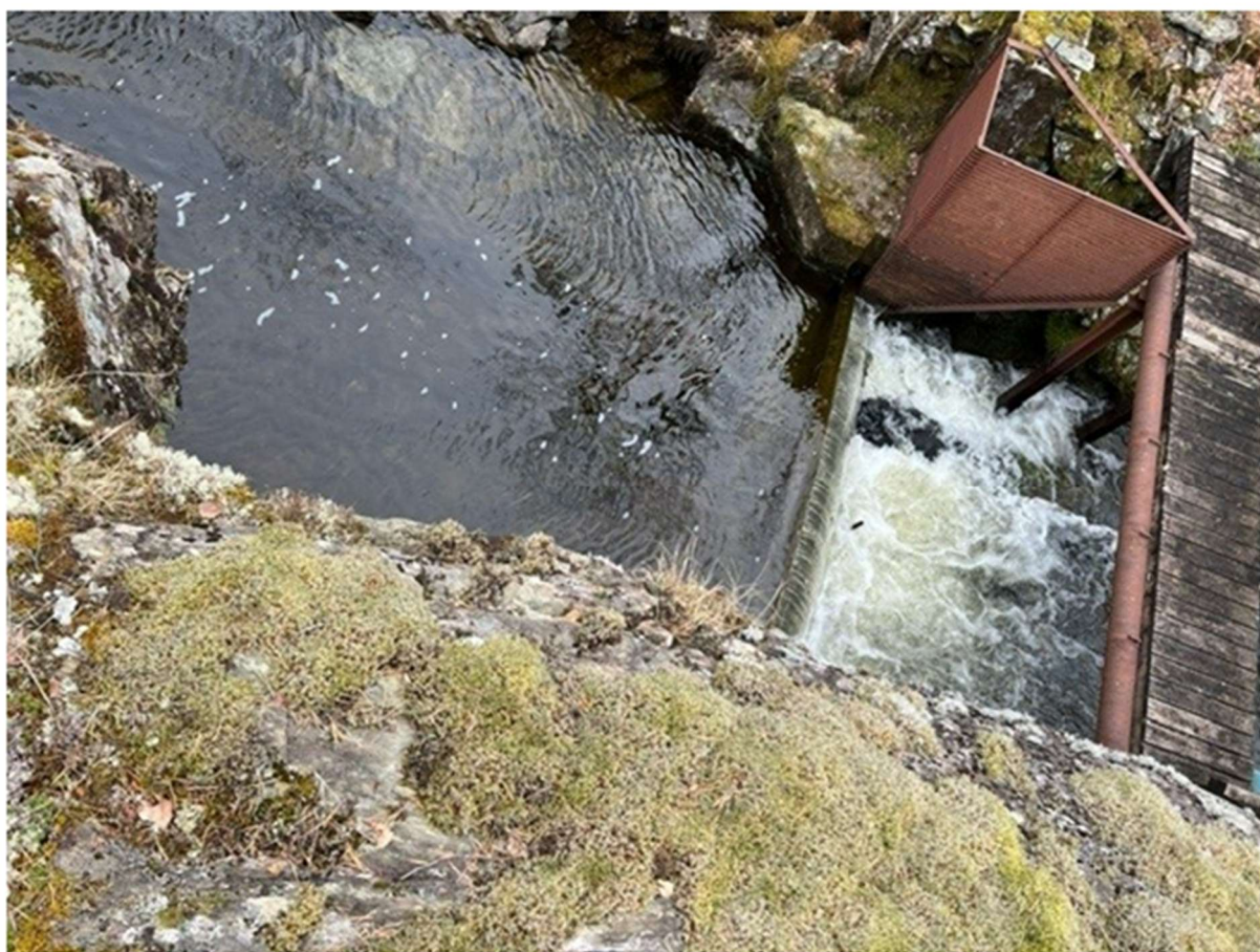
Figur 3. I enden av den utskutte kanalen i figur 2 , er det etablert en dam på 80 cm høyde og vel 2,5 meters bredde. Her var tidligere et oppvandringshinder for anadrom fisk, som i dag er fjernet, og søkes ikke reetablert.
