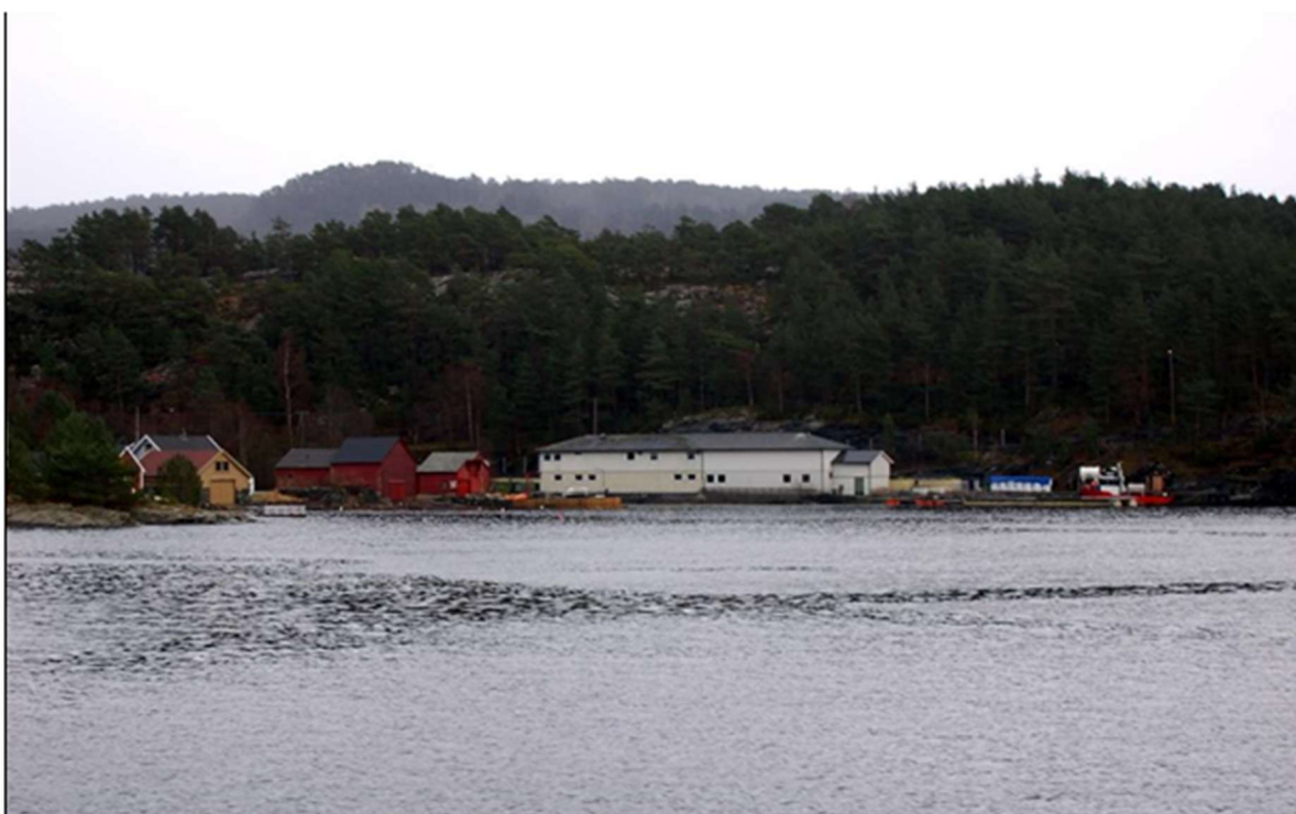
Figur 14. Det gamle settefiskanlegget sett fra sjøen.
