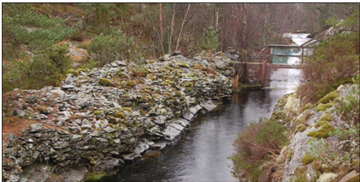
Figur 2. Utløpet fra Kvitebergsvatnet er kanalisert og senket tidligere, sannsynligvis for å hindre flomoppstuvning for landbruksarealene i indre deler av innsjøen. Dette arbeidet er av eldre dato.
