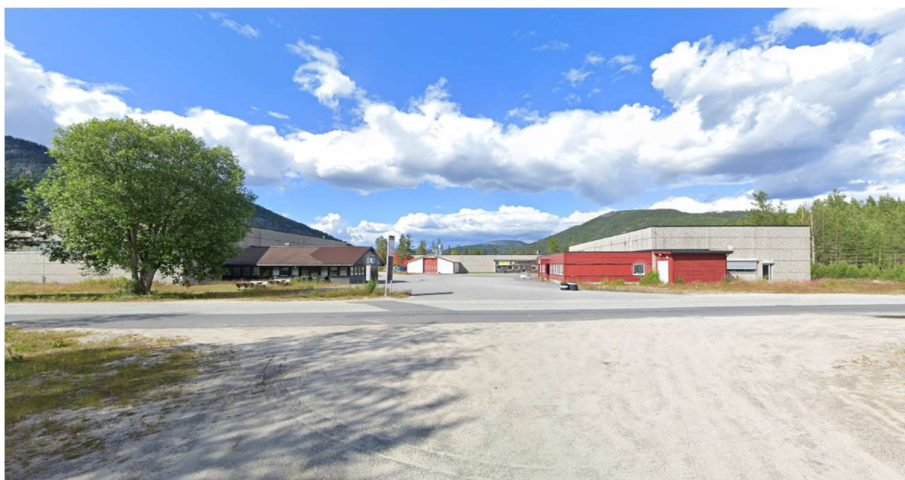
Figur 6-12: Industribygg på Molandsmoen. Foto: google street view.
