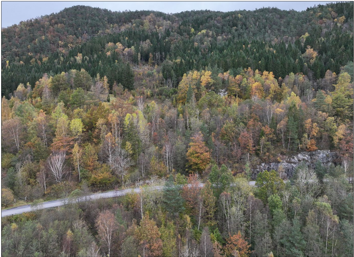
Figur 18: Dronebilde av øvre delar av påverknadsområdet, der det er bratt nok til utløyning av jord- og flaumskred. Handelsvegen kryssar påverknadsområdet i nedre del av bildet.
