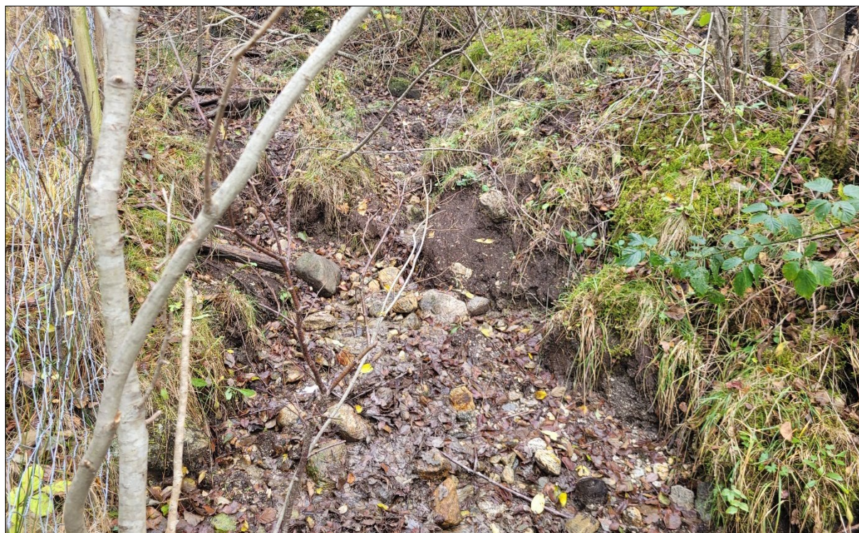
Figur 19: Erosjon/utvasking i jorda i dreneringsveg ved infopunkt 4.
