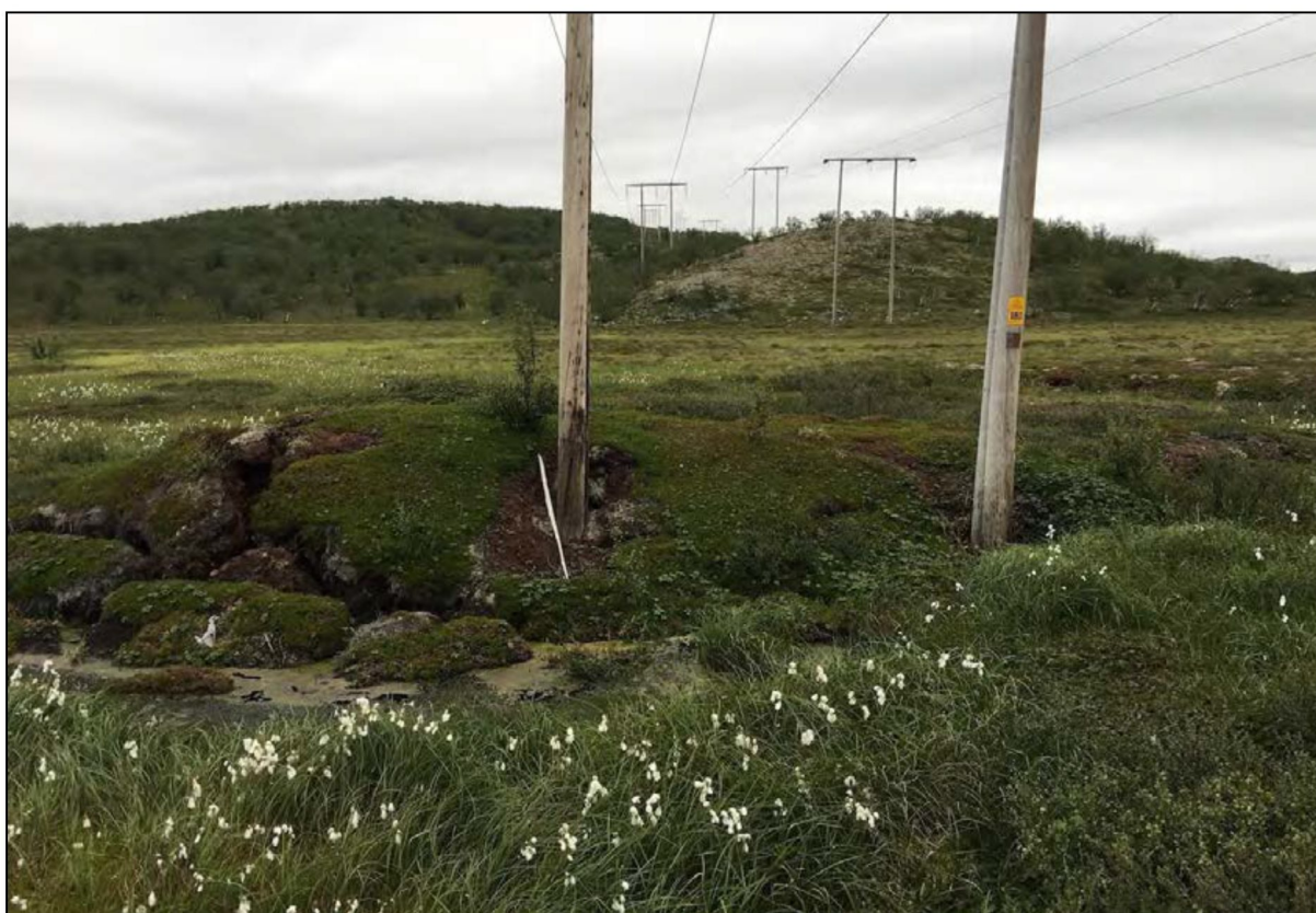
Figur 6-1. Eksisterende kraftlinje nordvest for Stabburnes har blant annet plassert ei mast midt i en pals i den verneverdige palsmyra Madarjeaggi. Mastene representerer her en klar trussel mot naturverdiene, både som følge av det fysiske inngrepet i seg selv, men ikke minst fordi mastene med tilhørende inngrep reduserer isoleringen av iskjerna i palsen og øker faren for at den kollapser. Foto: Geir Gaarder
