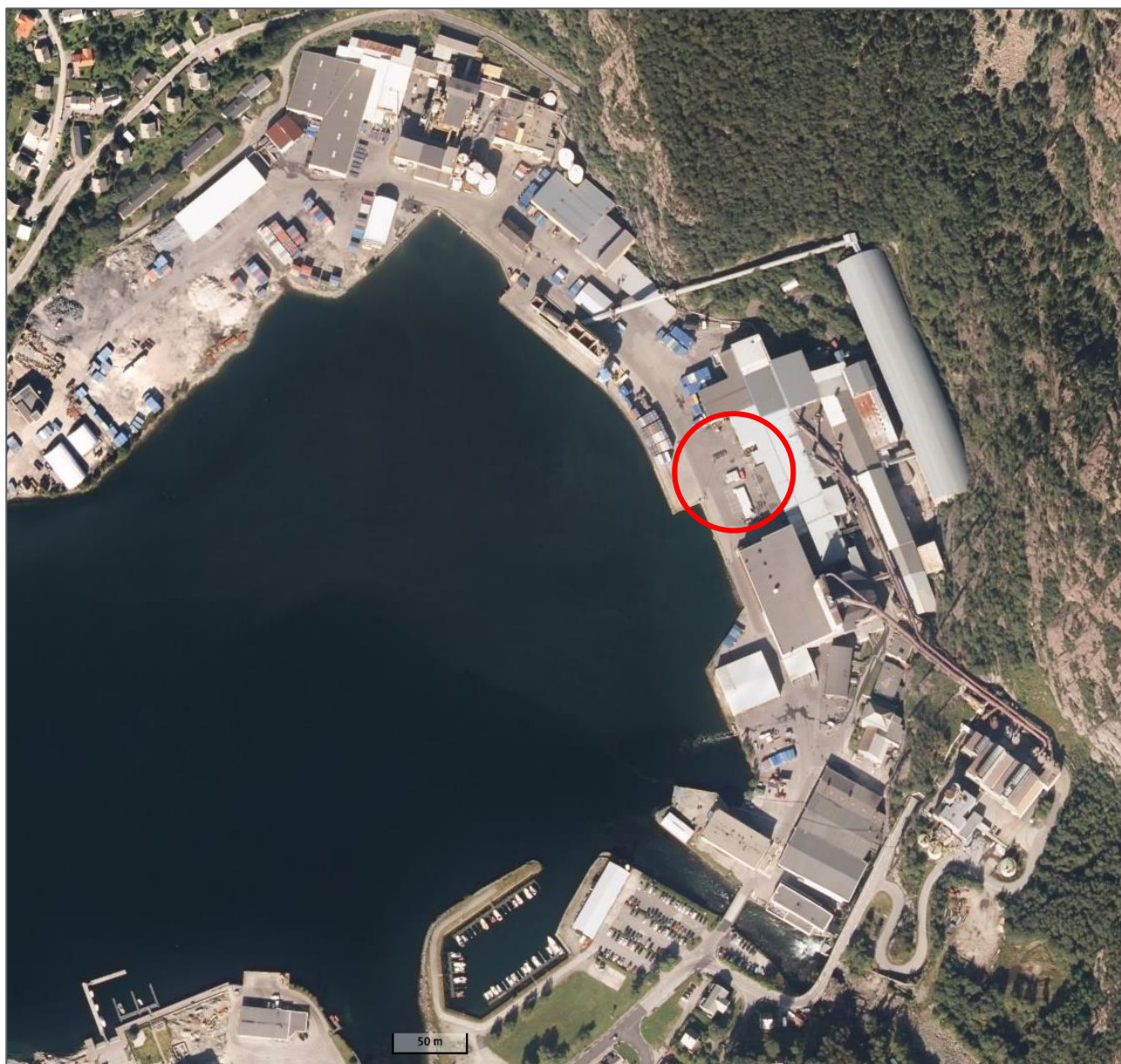
Figur 2: Flyfoto av det aktuelle området, Ref. 1. Undersøkelsesområdet er ringet inn med rød sirkel.
