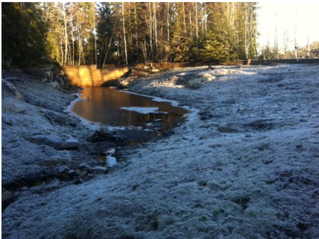
Figur 9. Øvre Askdam sett mot nord og dammen. Senket magasin høsten 2011
