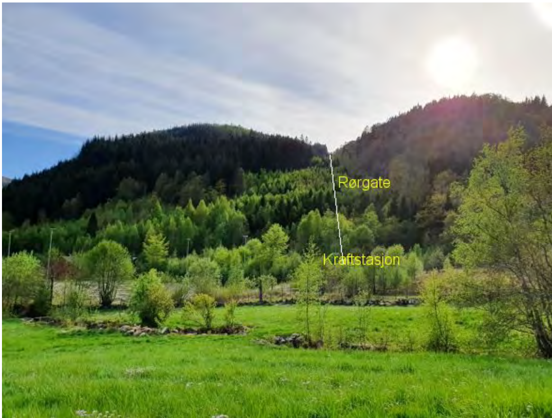
20220515_182718.jpg: Storli sett nedenfra. Rørgate og kraftstasjon markert.
