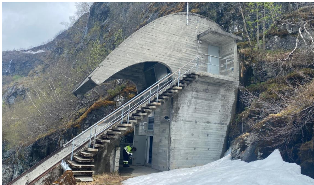
Figur 3-7 Eksisterende lukehus på østsiden av valldalsmagasinet.
