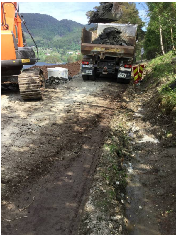
Ventilhus (kumringer) under arbeid i 2018.
