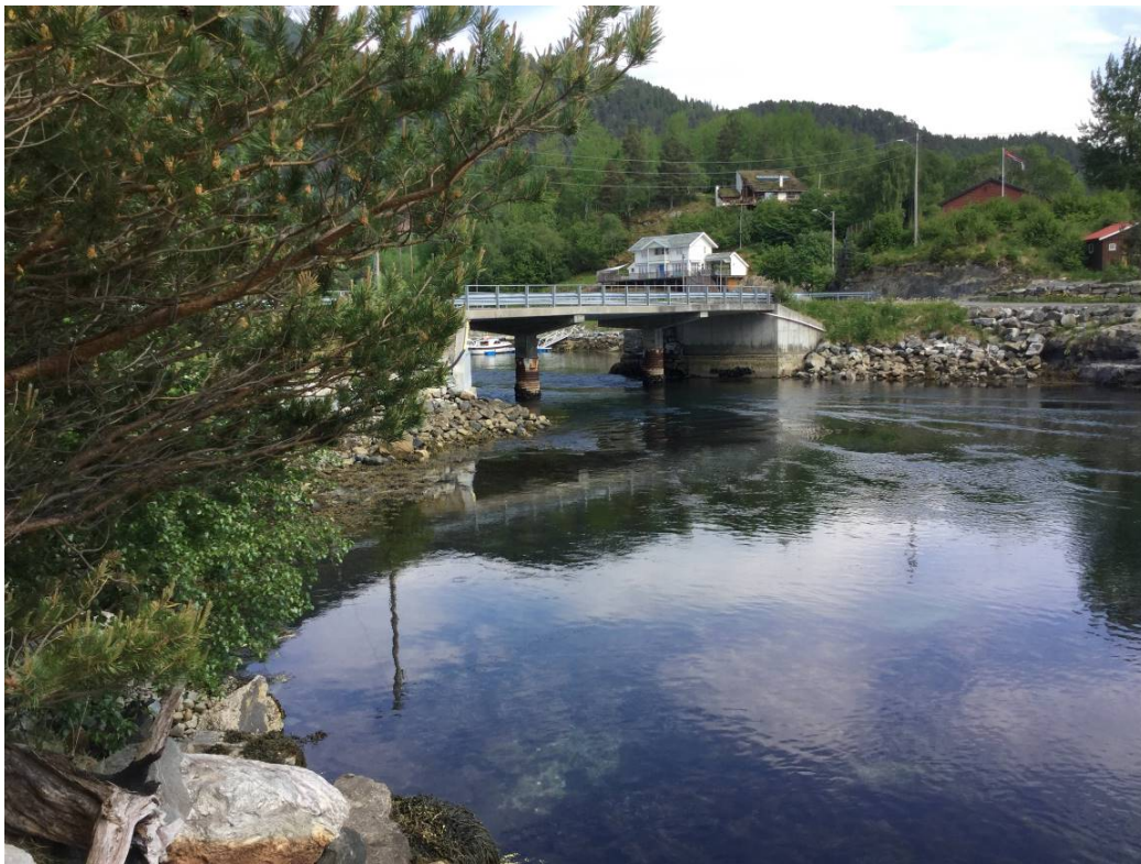
Bru ved Sunnmørshammaren.
