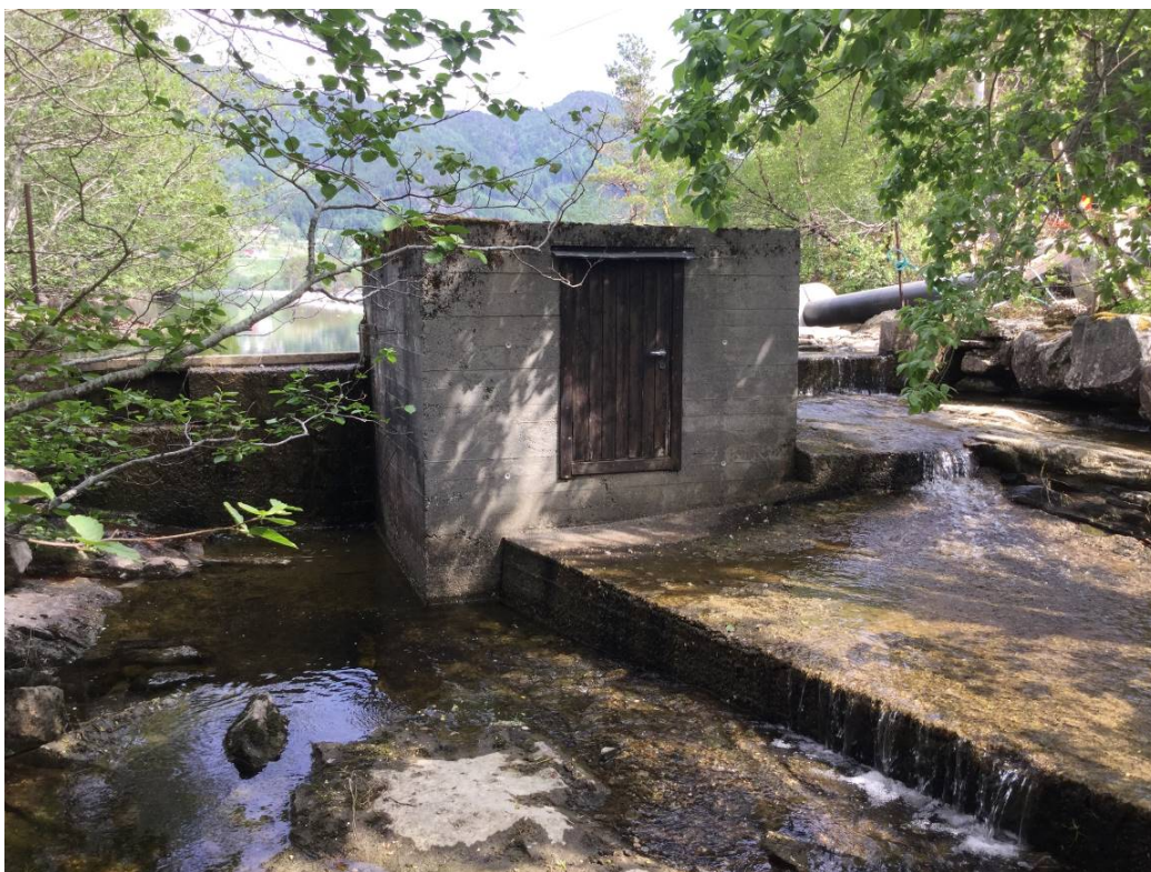
Inntaksdam i Hamreelva 35 moh. sett fra nedstrøms side.
