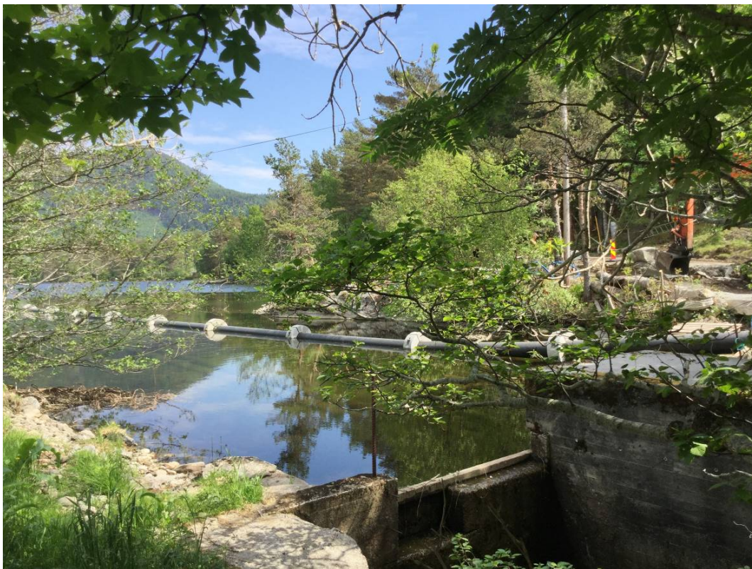
Gjerdsetvatnet oppstrøms dammen. Legging av ny vannledning pågikk i 2018.
