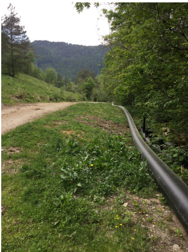
Traktorvei ca. kote 34. Ny vannledning skal graves ned i dagens veitrase.
