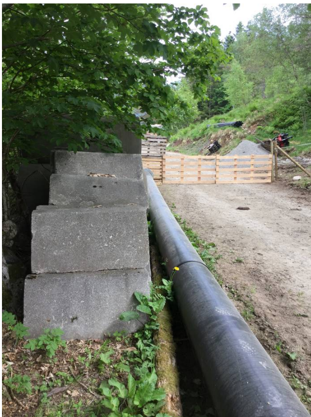
Grind over traktorvei like ved øverste bru. Kote 35.
