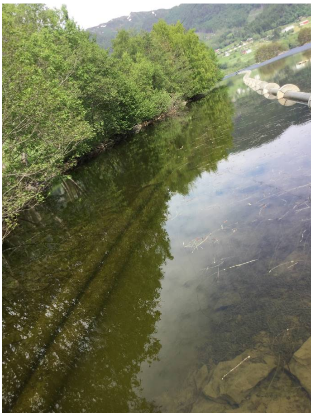
Ordinær vannledning på bunnen av Gjerdsetvatnet.
