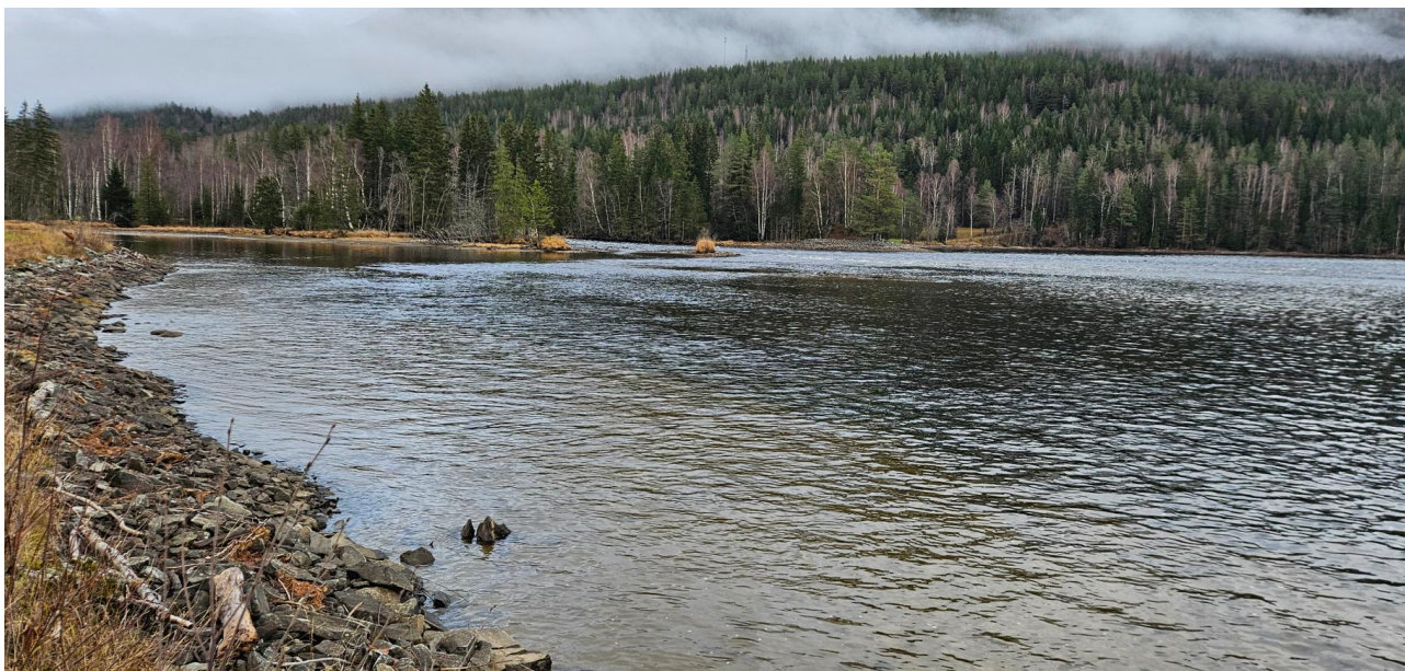
Figur 7 Innløpsområdet i Kravikfjorden ved Søre Eide. Sikringen av innmark med plastringstein sees til venstre i bildet.
