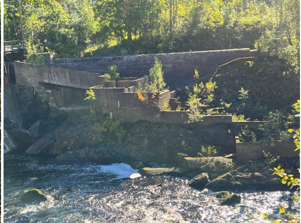
Venstre: Dam Søndeled. Høyre: Eksisterende fisketrapp og flomoverløp (Foto: Småkraftkonsult)
