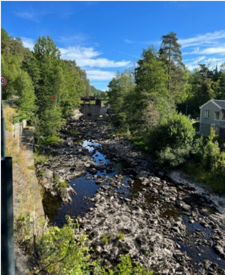
Figur 12 Lav vannføring nedstrøms Søndeled dam den 10.08.2022, med åpen bunnluke i dammen
