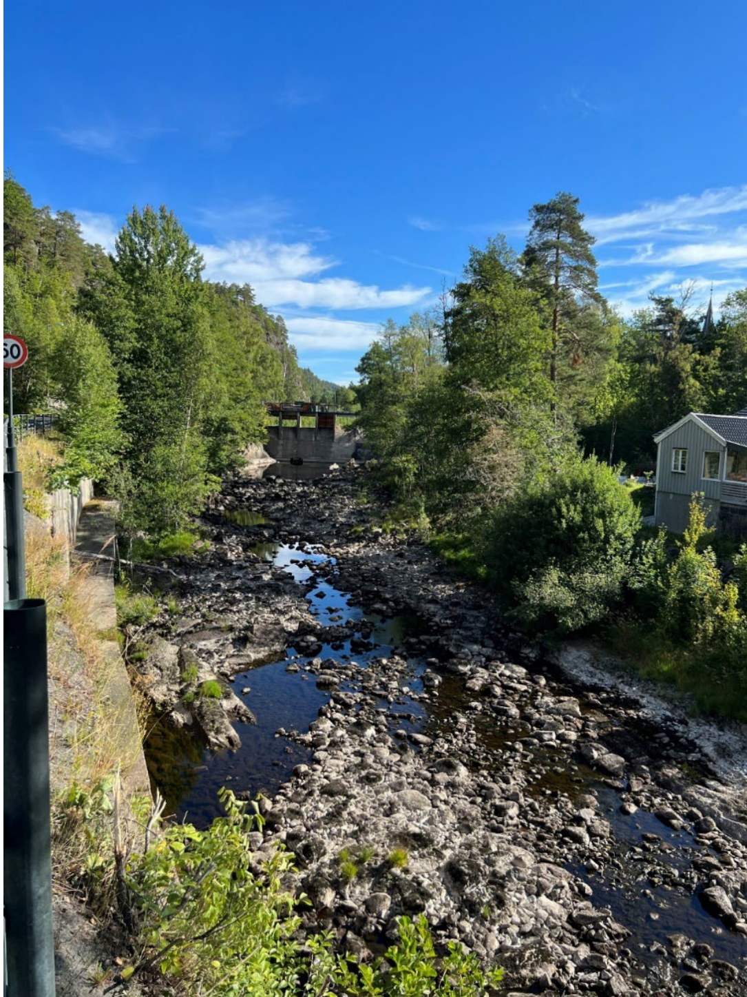
Fig 2.2.1. Lav vannføring nedstrøms Søndeled dam i Gjerstadvassdraget den 10. aug.2022. Elva her har flat bunnprofil og mangler dypål som oppvandrende fisk kan bruke på lave vannføringer. Minimumsfaktor i Gjerstadvassdraget er blant annet vannføring sommerstid. Situasjonen i bildet er at bunnlukene står åpne.
