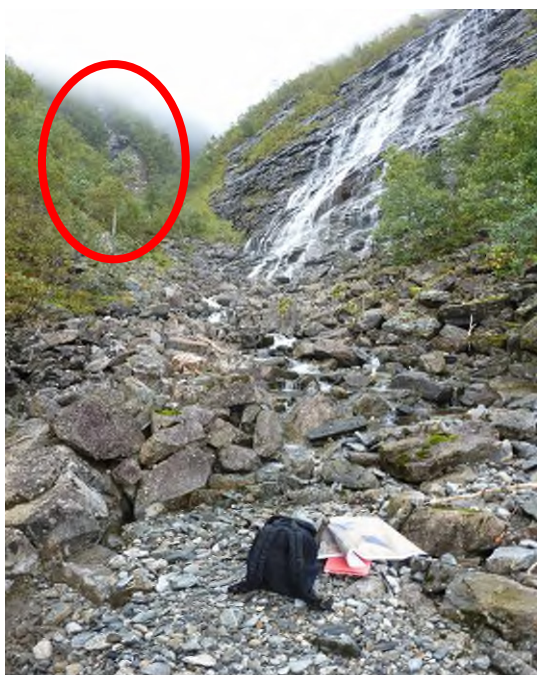
Figur 16: Skredmasser ved inntaket, med skred gått sommeren 2013 markert
