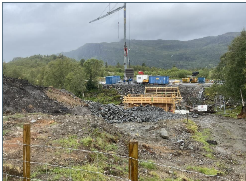
Figur 4-1 Arbeid med ny bru over Stølselva i forbindelse med reguleringsplan for E134 Røldalstunellen. Delar av anleggsområdet inngår i utredningsområdet for delområde Seljestad. Bilete er teke frå parkeringsområdet i delområde Seljestad mot E134. (09.08.2024)
