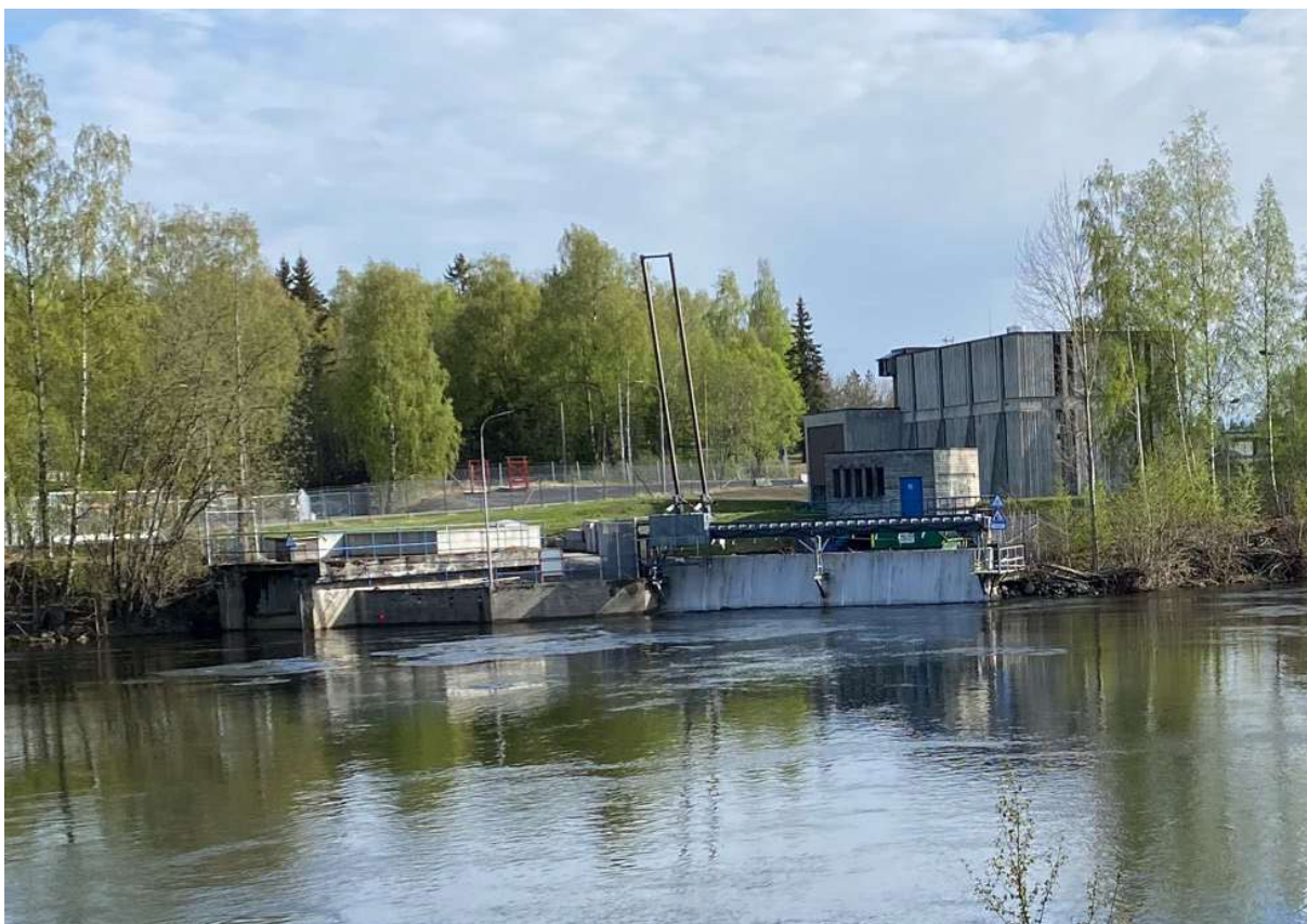
Figur 5 Inntak Hofsfoss Kraftverk
