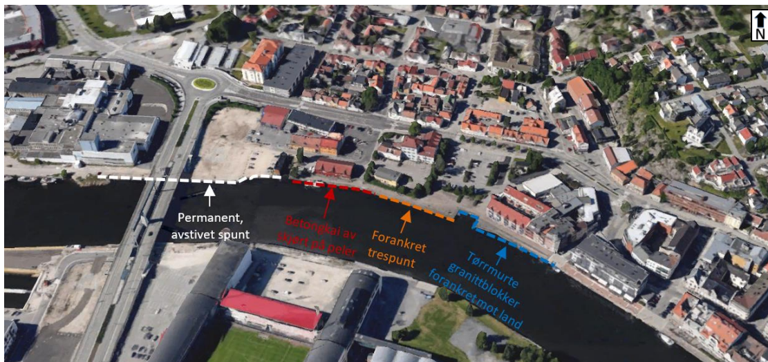
Figur 6.7: Antatt tilstand på kaifronten langs Trosvikstranda i dagens situasjon (earth.google.com)
