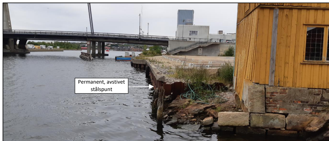
Figur 6.8: Kaifront mot Værstebua i vest, avstivet stålsput (Fra befaring 2020-08-26)
