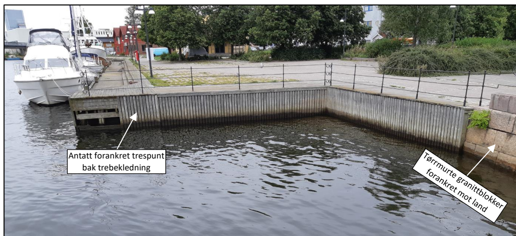
Figur 6.10: Kaifront ved Evjekaia og mot vest (befaring 2020-08-26)
