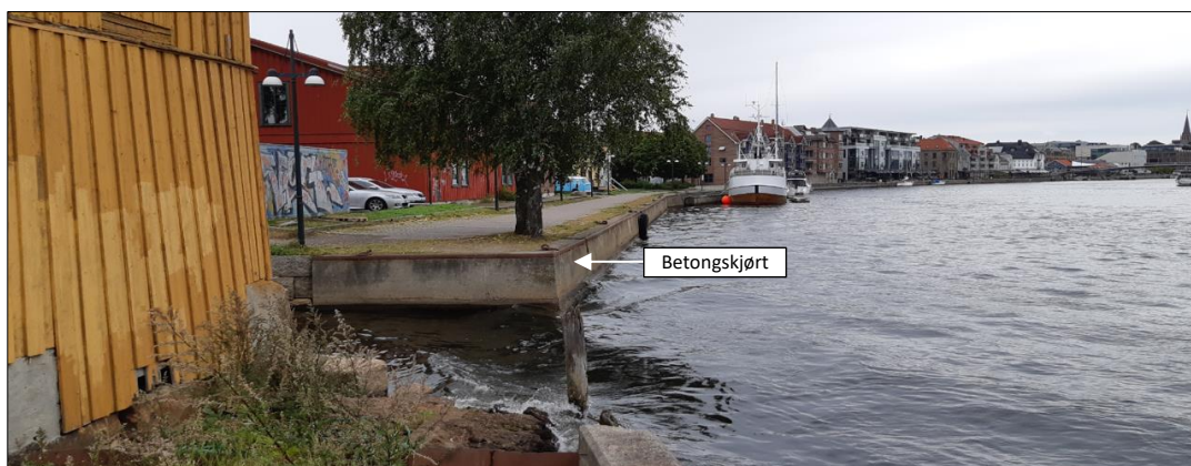
Figur 6.9: Kaifront ved båtbua mot øst, betongskjørt (befaring 2020-08-26)
