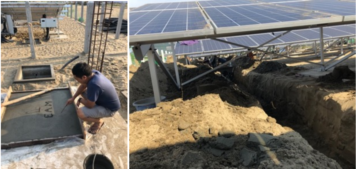
Figur 6-4 Støping av fundament i løsmasser, bildet fra Myanmar, Kilde Energeia AS
