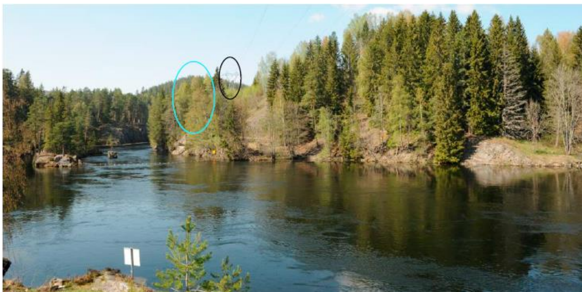
Figur 2: Eksisterende ledning og mastefeste langs kanalen i alternativ sør sett i retning mot Vrangfoss. Vegetasjonen ut mot elva må fjernes ved bygging av ny kraftledning etter dette alternativet.
