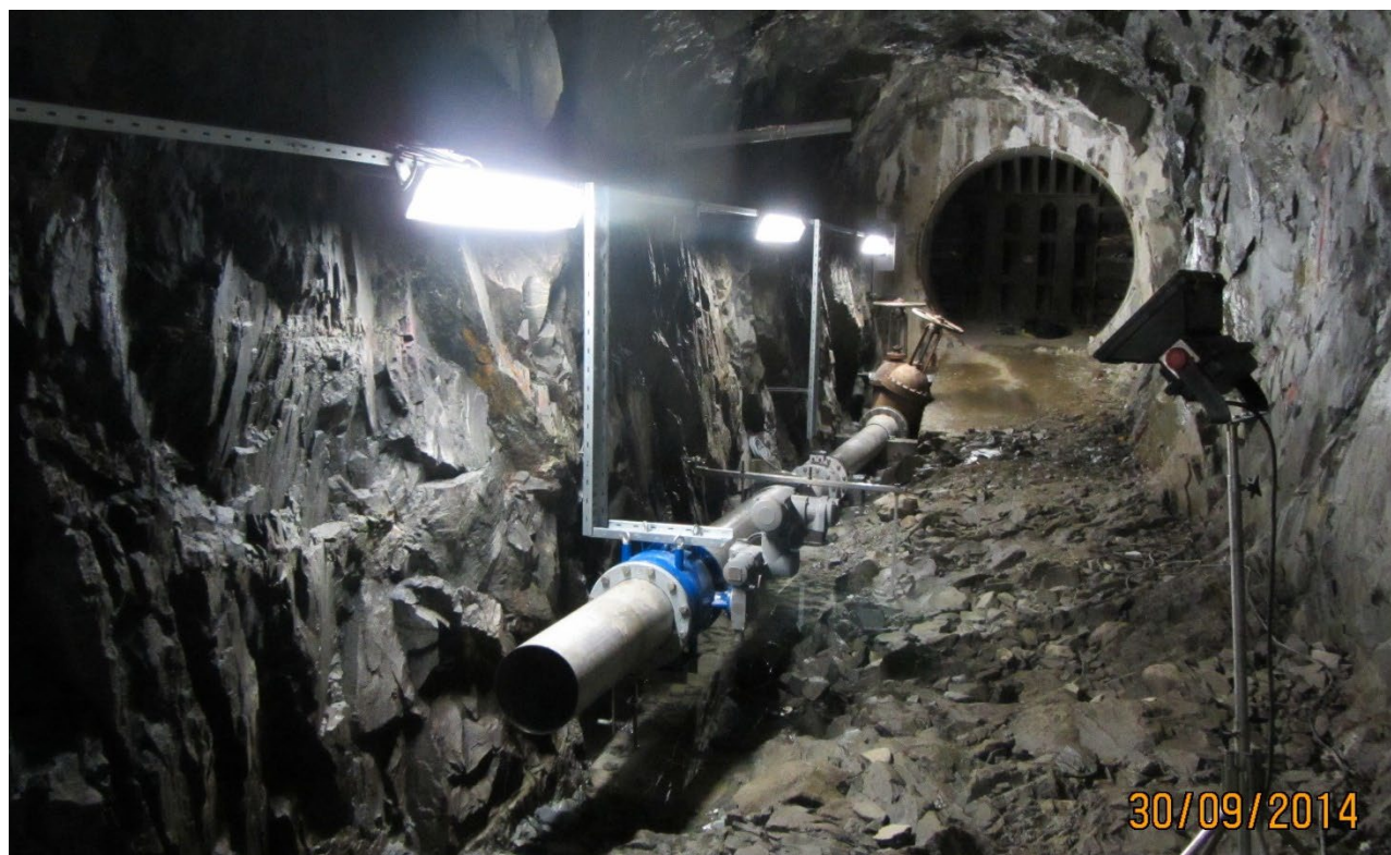
Bilde 3 -Eksisterende tappearrangement i tverrslaget.
