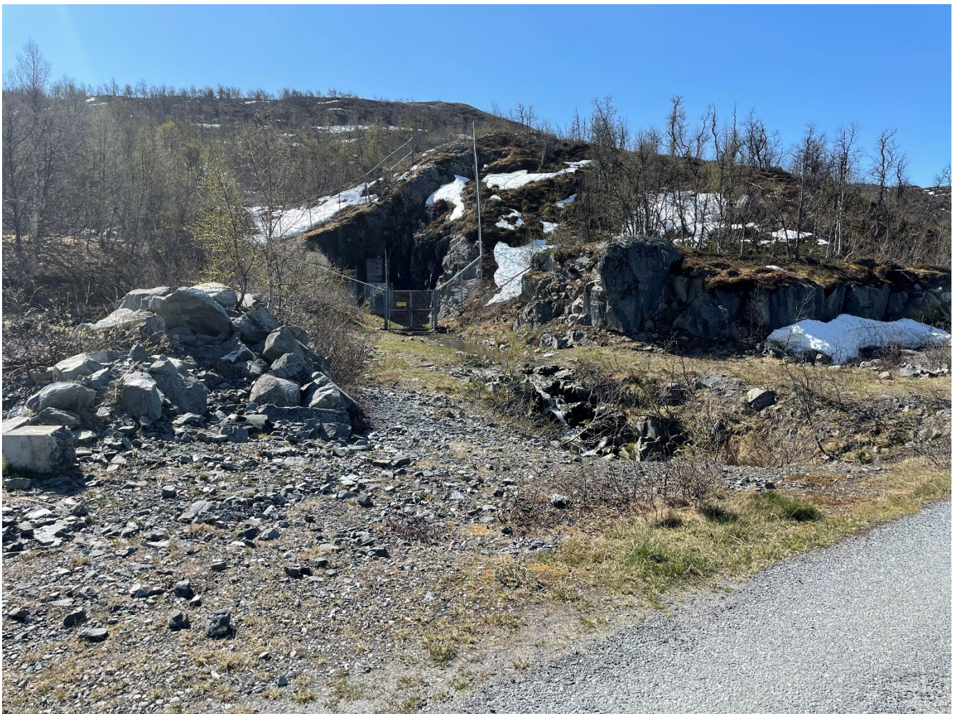
Bilde 4 - Tverrslag 1 Usta, nåsituasjon
