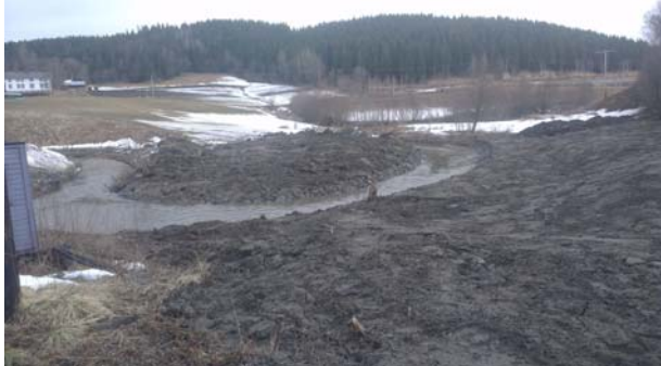
Fylling P085. Myrelvas nye løp.
