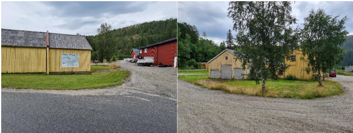
Figur 3: Batterioppstillingsplassen sett fra østsiden (venstre) og nordvestsiden (høyre)
