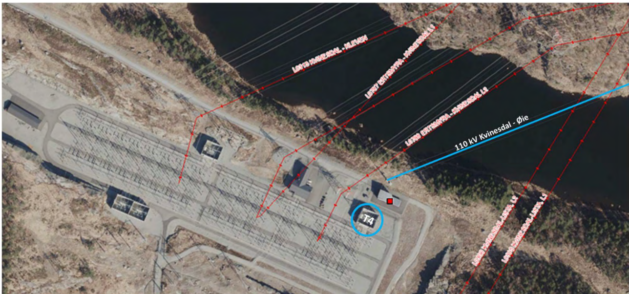
Figur 4-6: Flyfoto over Kvinesdal transformatorstasjon. Kvinesdal koblingsstasjon ligger øverst til høyre på stasjonstomten og eies av AEN. 110 kV luftlinjen fra Øie kommer inn i stasjonen fra øst. De resterende luftlinjene er transmisjonsnett-forbindelser, illustrert med rød strek fra NVE-Atlas.
