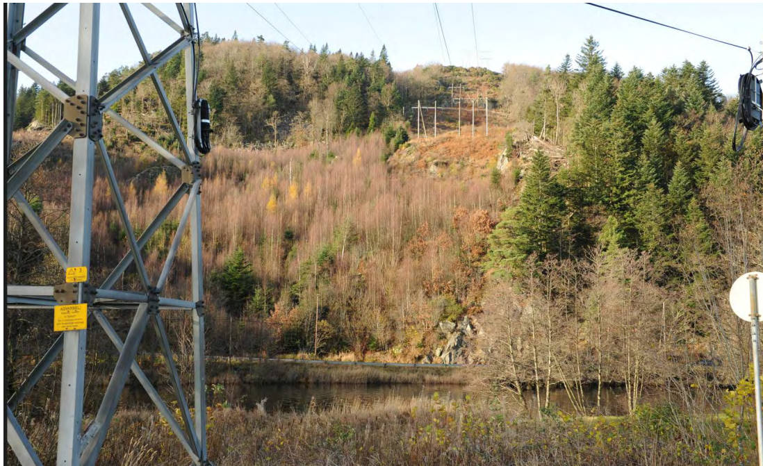
Figur 11-10: Bildet er tatt mot nordvest fra dagens dobbelkursmast på østsiden av elva Audna og viser eksisterende 110 kV linjer mot Lyngdal og Ramslandsvågen (linjen til venstre i bildet).
