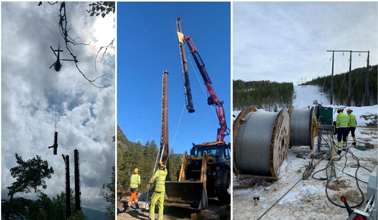
Figur 10-3: Etter premontering på riggplass flys mastene i deler ut til mastepunktet (bildet til venstre) eller fraktes med bakketransport (bildet i midten). Linene trekkes med vinsj (bilde til høyre) etter at pilotlinje er flydd ut med helikopter.
