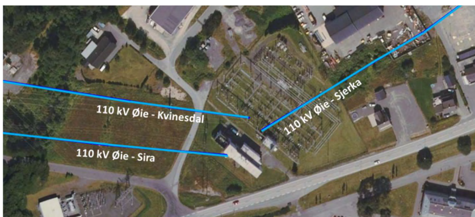
Figur 4-5: Flyfoto over Øie transformatorstasjon. Mot nordøst går 1 stk. luftledning mot Skjerka og mot nordvest går en luftledning mot Sira og en mot Kvinesdal.
