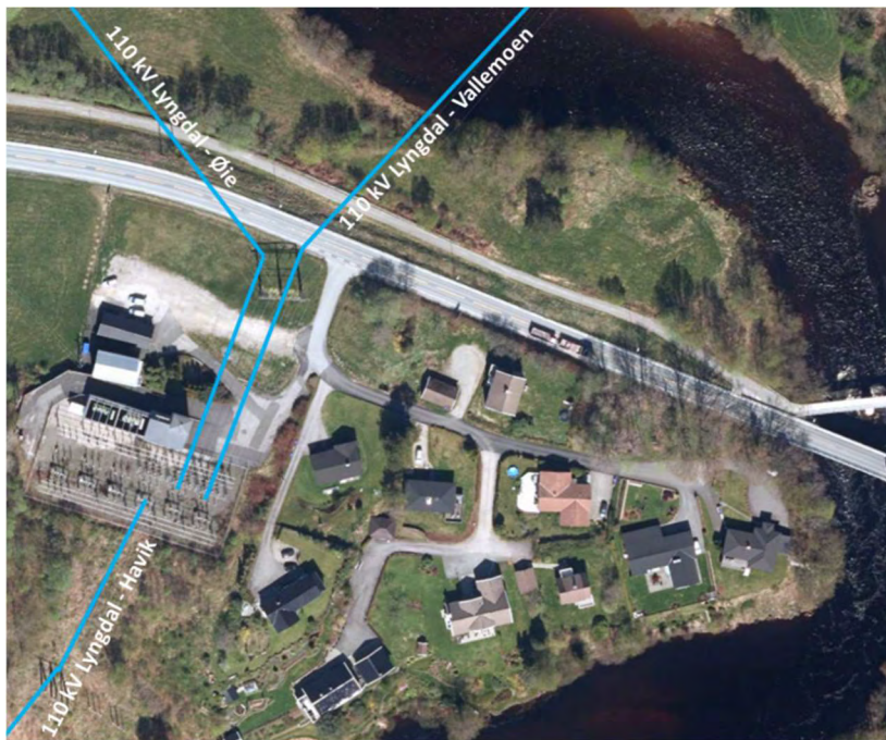
Figur 4-4: Flyfoto over Lyngdal transformatorstasjon. Ledningen fra Havik kommer inn fra sør. Mot nord går 1 stk. ledning videre østover mot Vallemoen og 1 stk. lending vestover mot Øie.
