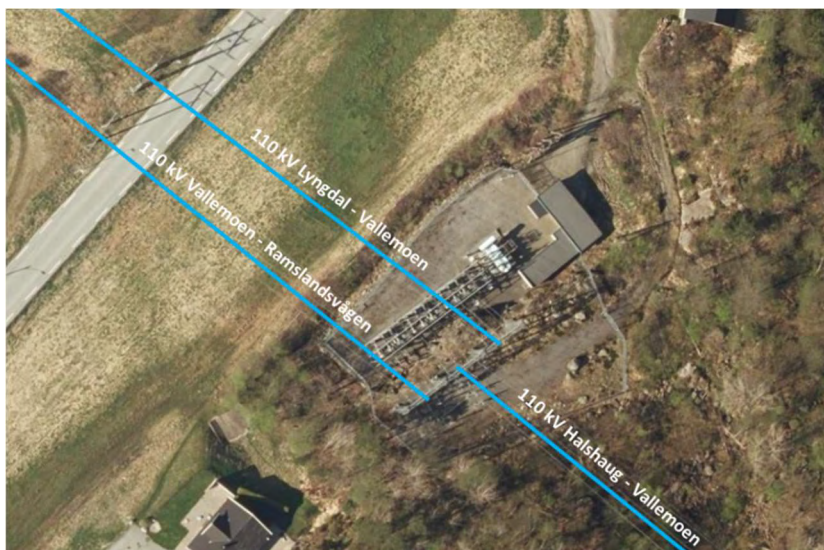
Figur 4-3: Flyfoto over Vallemoen transformatorstasjon. 110 kV-ledninger markert med blå linjer
