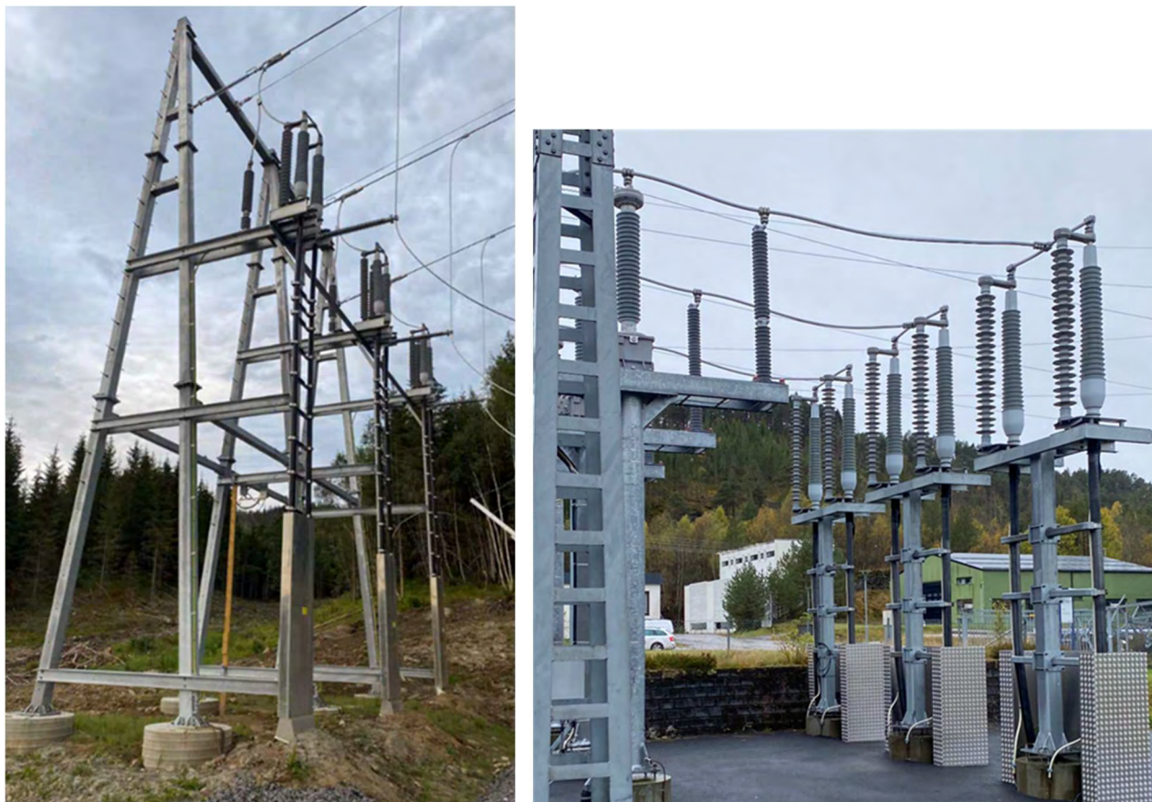
Figur 11-6: Bildet til venstre viser eksempel på kabelendemast for 132 kV ledning og 2 stk. kabler per fase. Bildet til høyre viser eksempel på kabelstativ med muffe og avleder for to kabler per fase.
