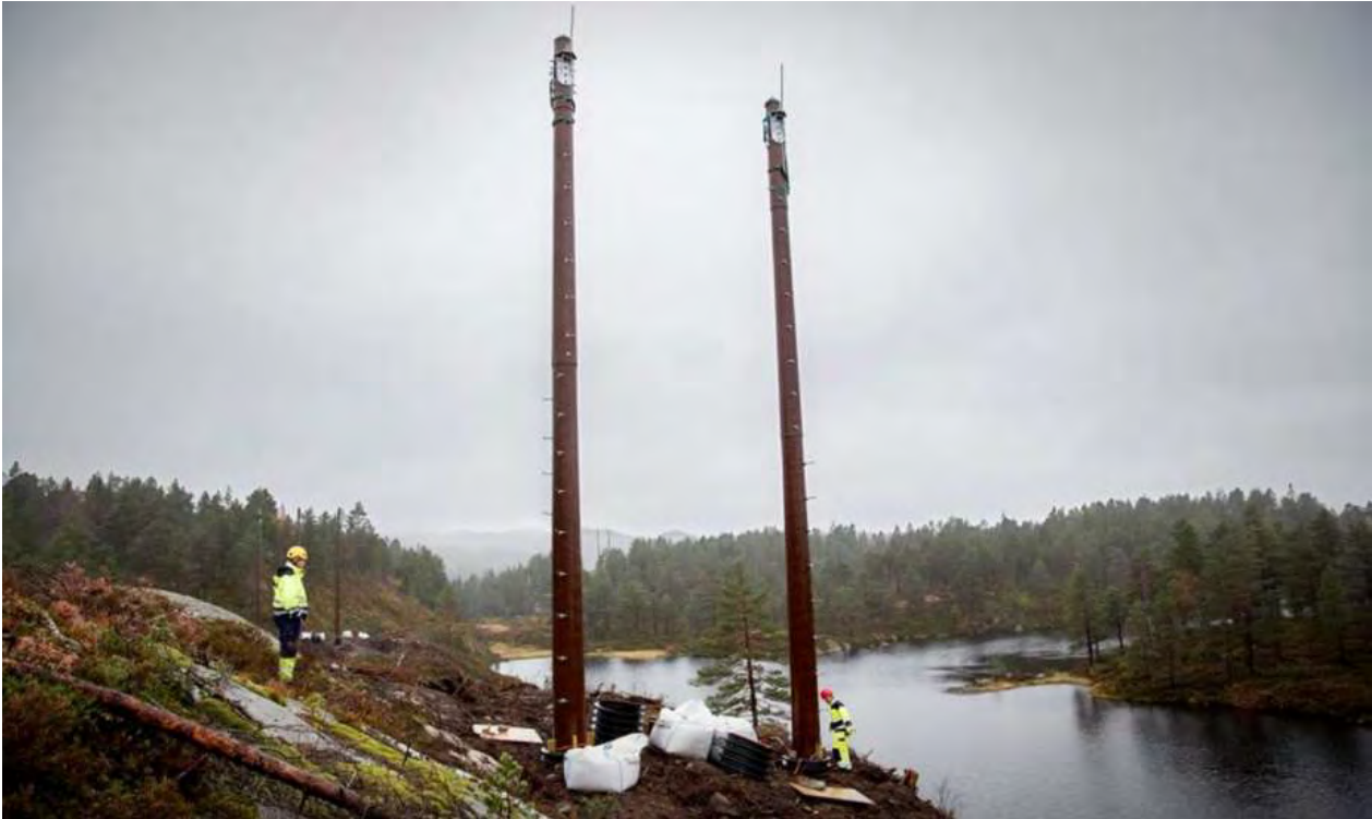
Figur 10-2. Mastene er heist på plass. Både kompositt og stålmaster leveres i brunfarge som her.
