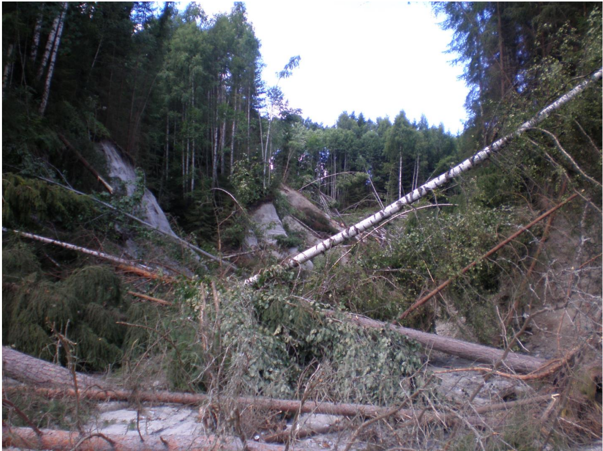
Figur 5: Bilde 4 viser raskanten.
