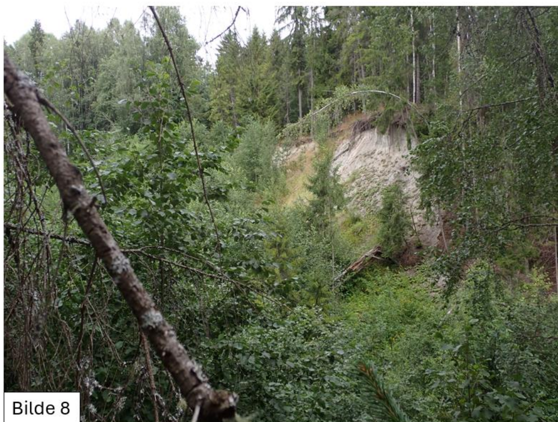
Figur 10: Bilde 8 viser løsmasser i skredgrop.
