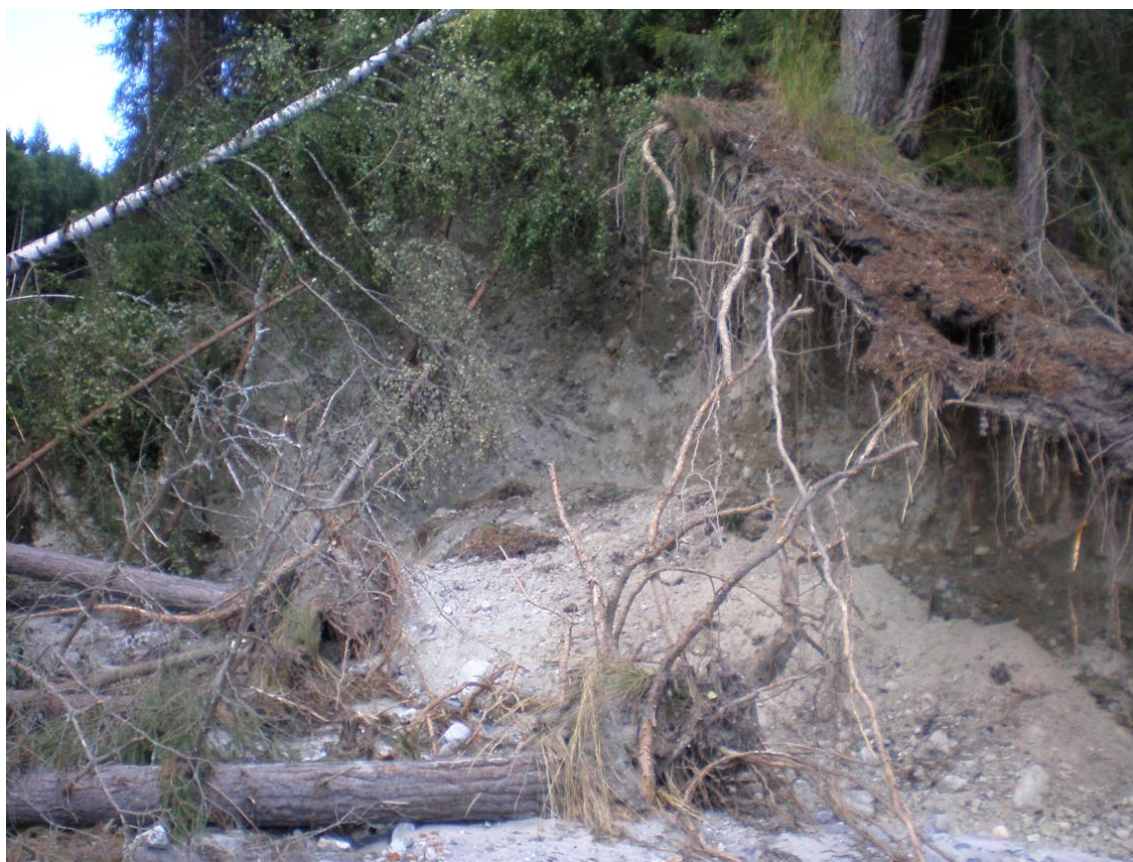
Figur 4: Bilde 3 viser raskanten.
