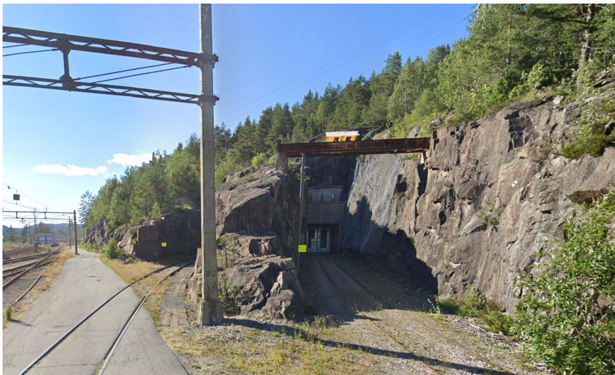
Figur 1 Eksisterende omformerstasjon (fjellanlegg) til Bane Nor ved Nelaug stasjon
