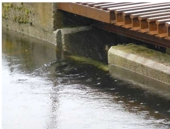
Figur 29 Dagens utløp med spalt.
