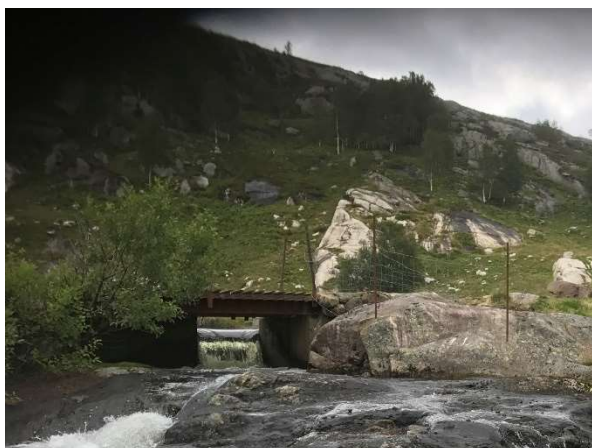
Figur 30 dagens dam sett nedenfra.
