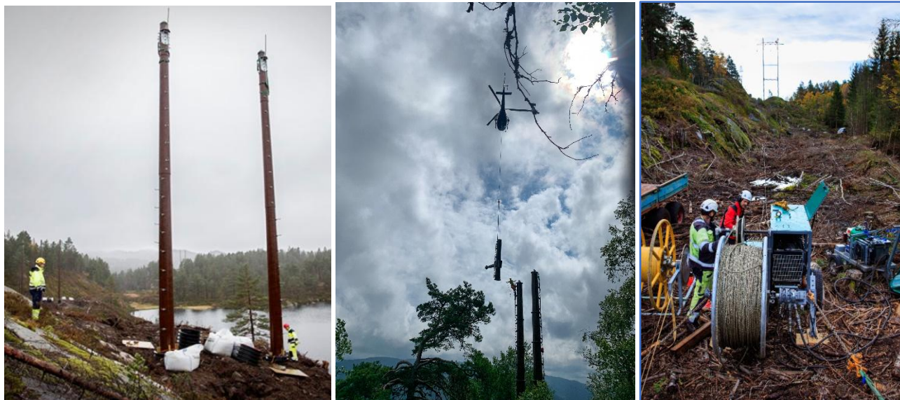
Figur 3-8. Mastene er heist på plass. Både kompositt og stålmaster leveres i brunfarge som i bildet til venstre. Etter premontering på riggplass flys mastene i deler ut til mastepunktet. Linene trekkes med vinsj (bilde til høyre) etter at pilotlinje er flydd ut med helikopter.
