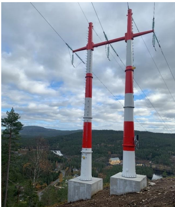
Figur 3-5. Eksempel på flymarkert mast med rød og hvit maling til venstre og master med refleks til høyre.
