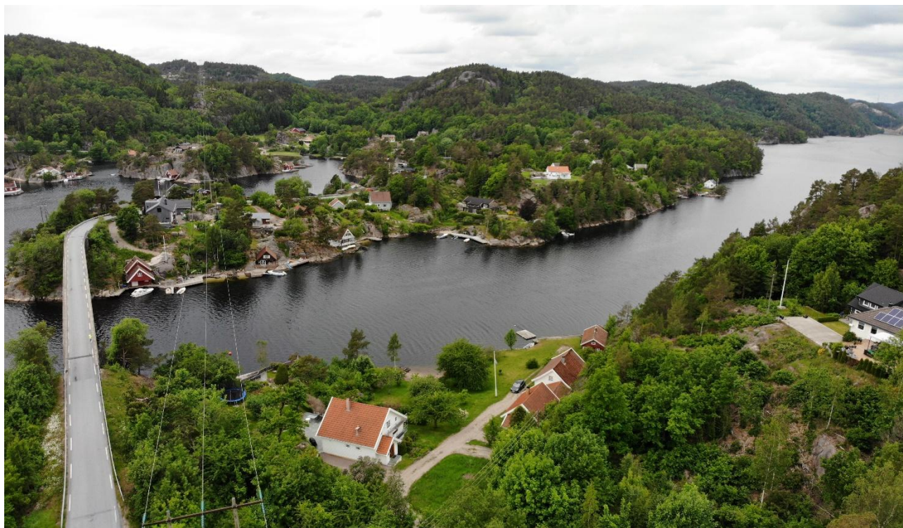
Figur 7-6. Dagens situasjon ved Trysfjorden (visualisering 3). Eksisterende ledning til venstre i bildet.
