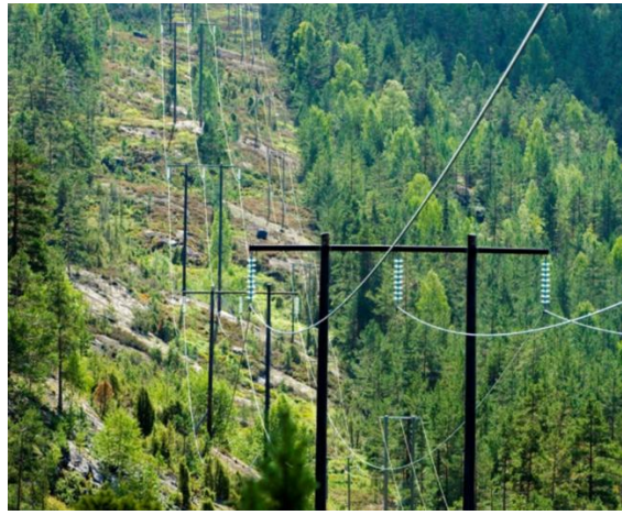
Figur 3-7. Rydding av skog i ledningstraseene gjøres i hovedsak med skogsmaskiner slik skogbruket driver i dag. Eksempel på ryddebelte langs kraftledninger.
