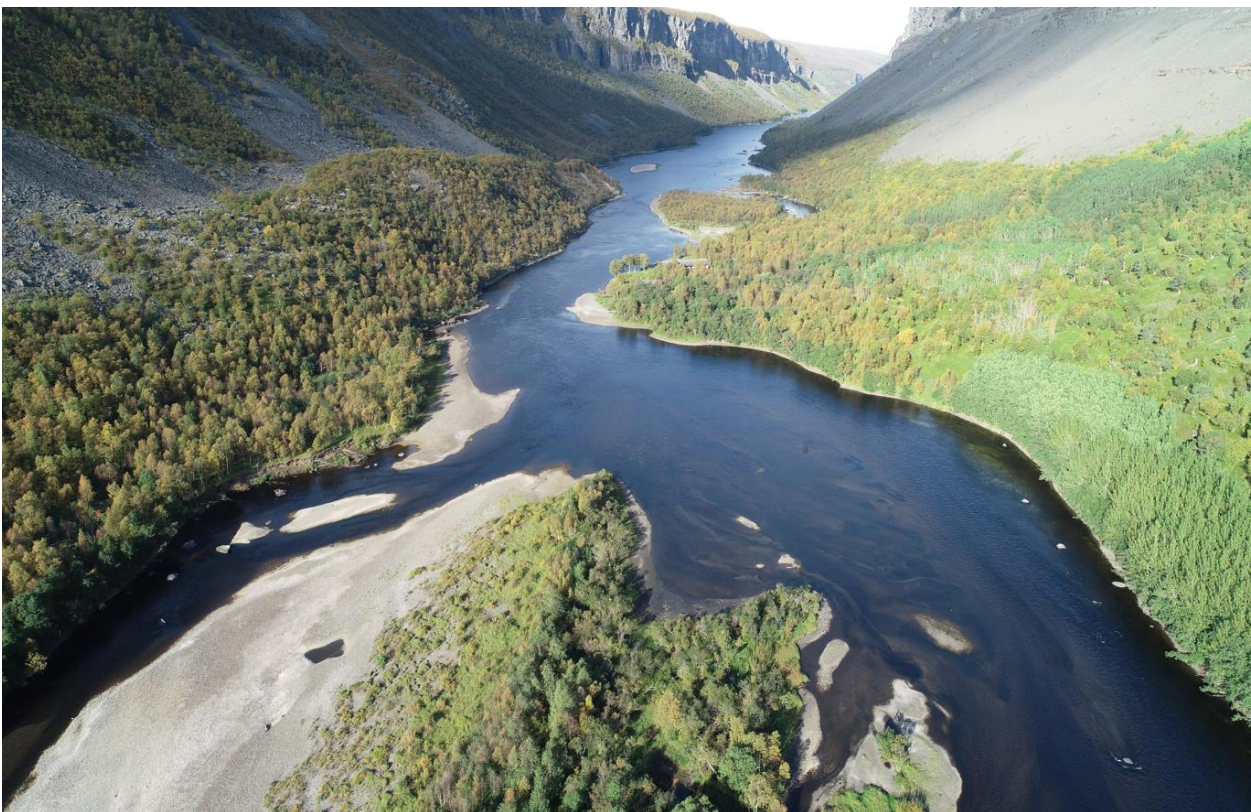
Dronefoto ved Altaelvas utløp i Sauto, sett medstrøms. Foto: Sweco, 05.09.2024.
