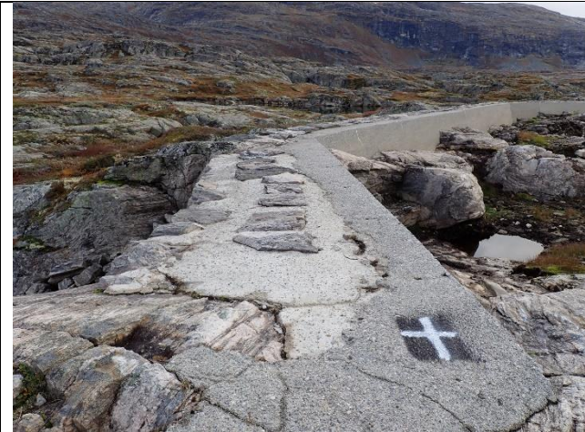
Bilde 7: Damkrone dam 1
