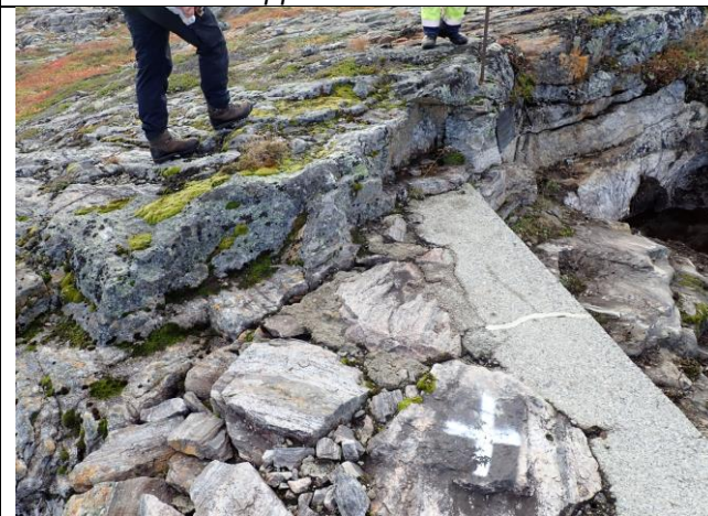
Bilde 11: Dam 2 – Høyre vederlager
