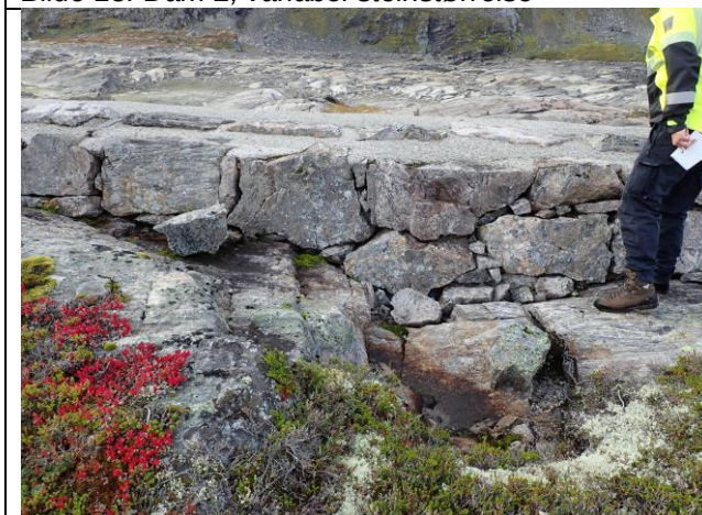
Bilde 17: Lav del av dam 2
