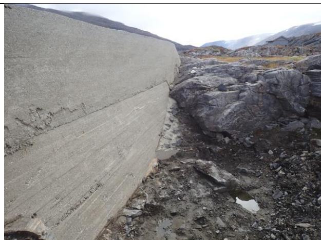
Bilde 14: Støpt ut i bunn av dam 2, oppstrøms side
