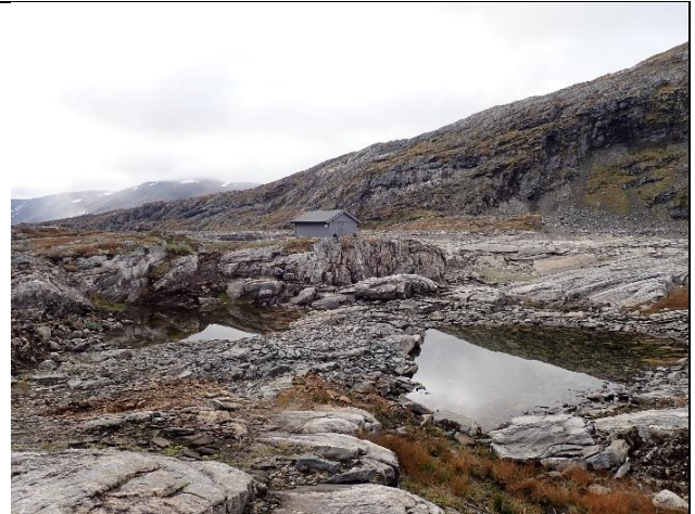
Bilde 8: Magasin oppstrøms dam 2
