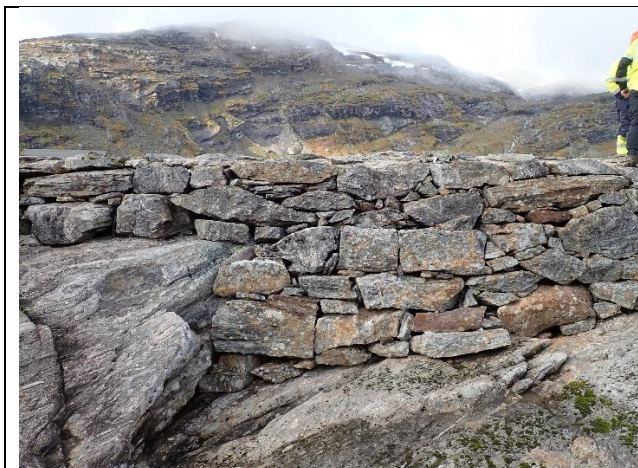
Bilde 13: Dam 2 – Nedstrøms mur
