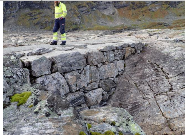
Bilde 6: Nedstrøms side av dam 1
