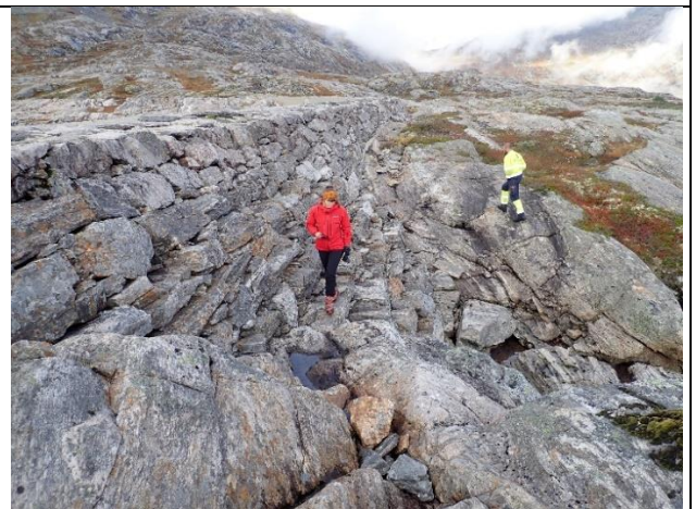
Bilde 12: Dam 2 – Nedstrøms side, høyeste del av dammen
