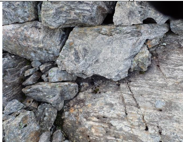
Bilde 16: Dam 2 - Stein på vei ut av dam
