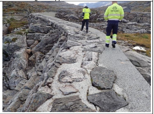
Bilde 10: Damkrone dam 2
