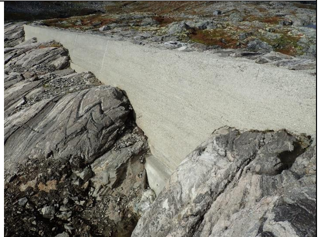
Bilde 28: Dam 5 - damplate
