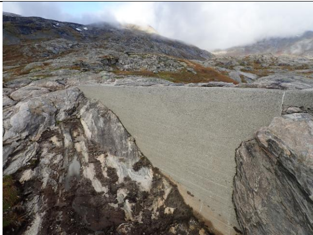
Bilde 5: Dam 1, oppstrøms, Dam 1 – "adskilt" fra dam 2 av berg som går høyt opp i/gjennom dammen
