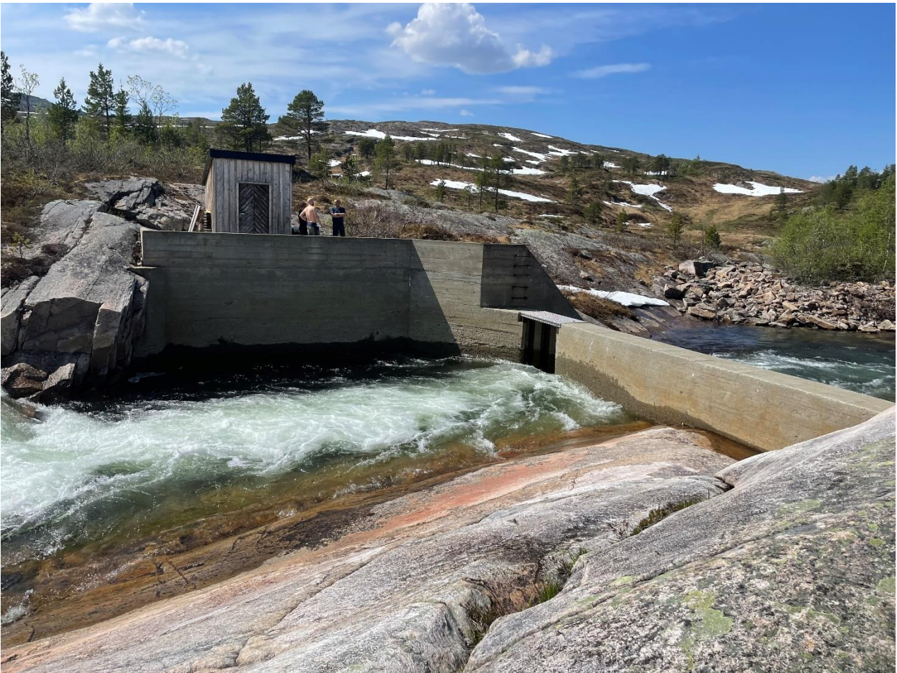
Bekkeinntak Store Bulu.
