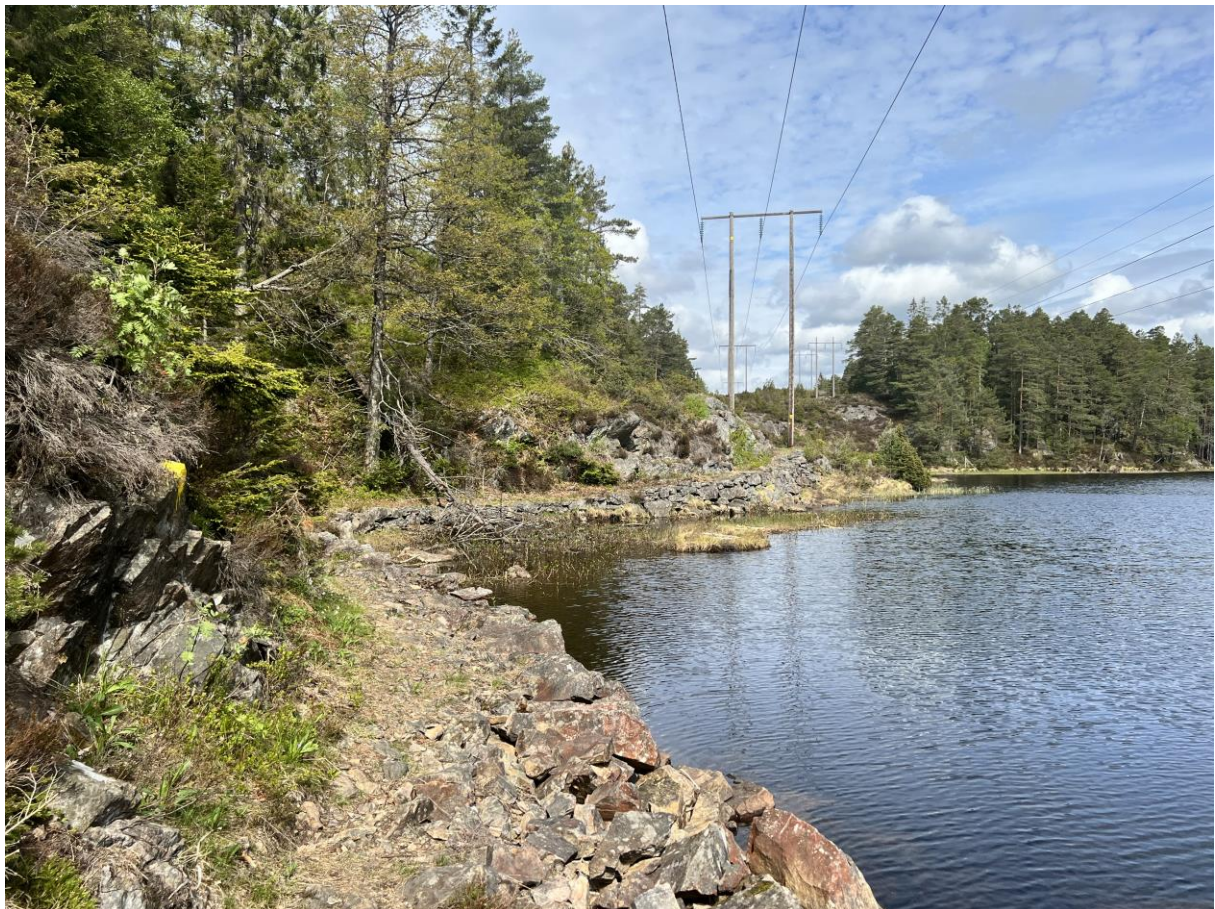
Figur 5. Del av oppbygd vei/tursti ved Bukketjern. Sett mot nordvest.
