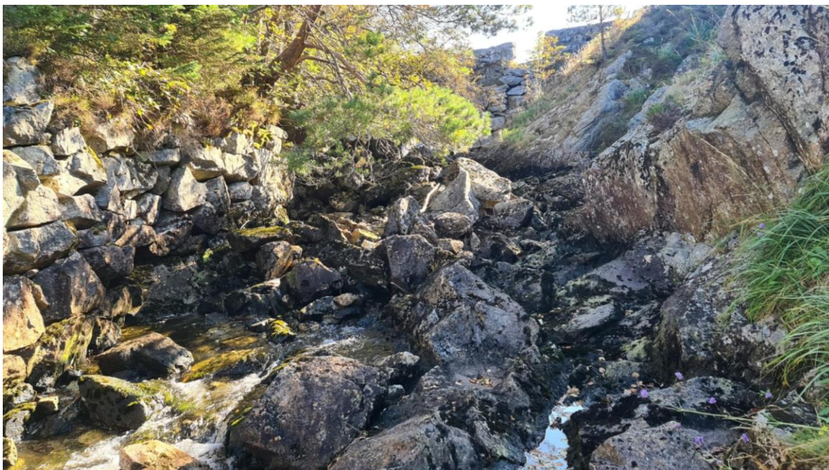
Figur 5915: Bekkefareet nedenfor demningen ved «lav» vannføring (dato 24.08.2025).
