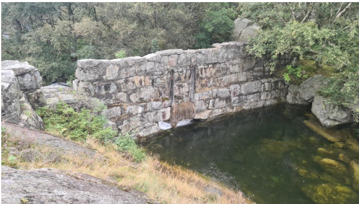
Figur 57: Demningen ved utløpet av Hølen ved høy vannføring (dato 07.08.2025).
