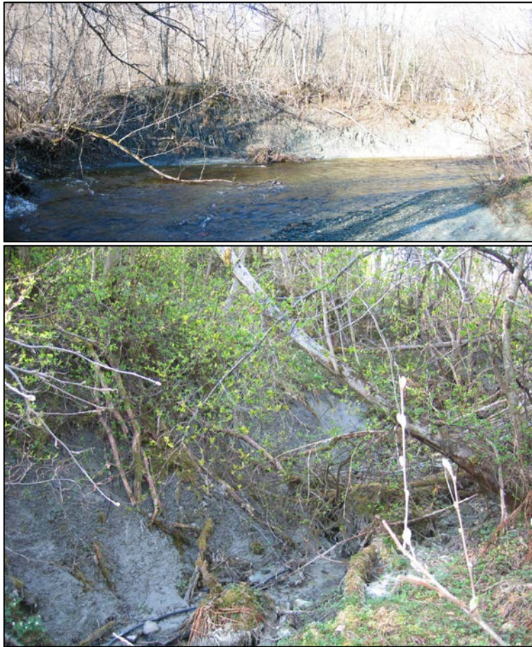
Figur 4. Før erosjonssikringstiltaket: Leirelva ved Selsbakk (øvre bilde) og sidebekk fra Romolslia til Leirelva (nedre bilde) i 2005 (bilder fra [2])
