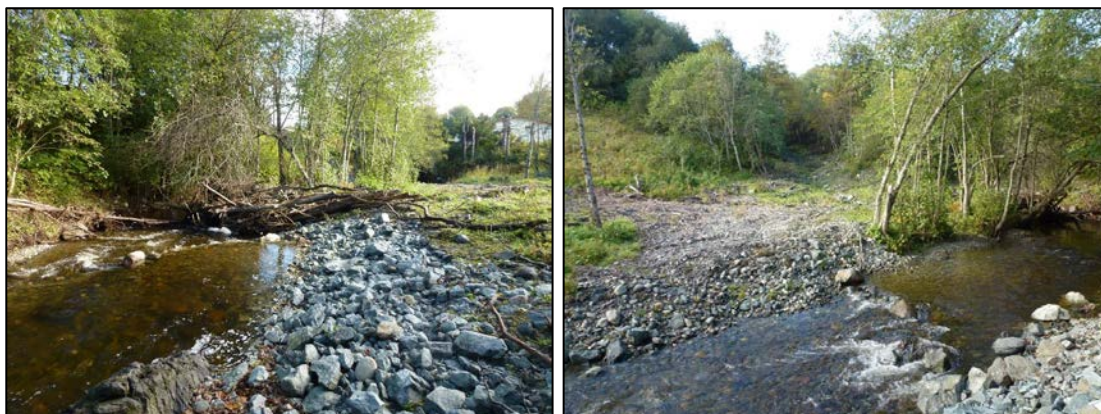
Figur 5. Leirelva etter erosjonssikringstiltaket i 29.09.2022 (bilder fra [3]).
